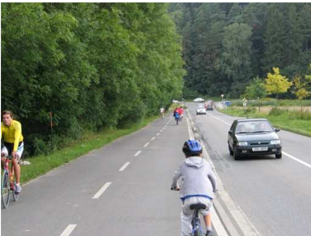
ilustrační foto – obousměrná stezka na společném tělese vozovky (Zlínsko)
