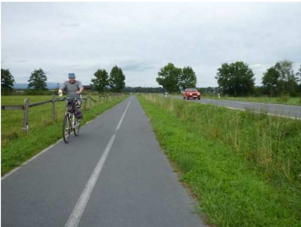
ilustrační foto – obousměrná stezka na samostatném tělese (propojení Litovel-Uničov)
