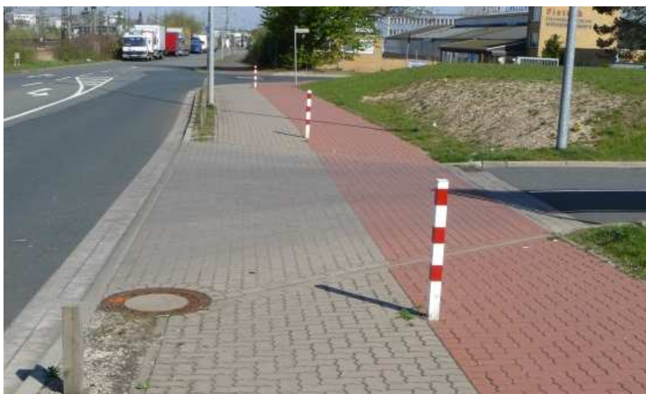
obr 2 - příklad řešení přejezdu stezky (stavebně je jasně odlišena priorita pohybu – v souladu se zákony 13/1997 Sb. a 361/2000 Sb.)
