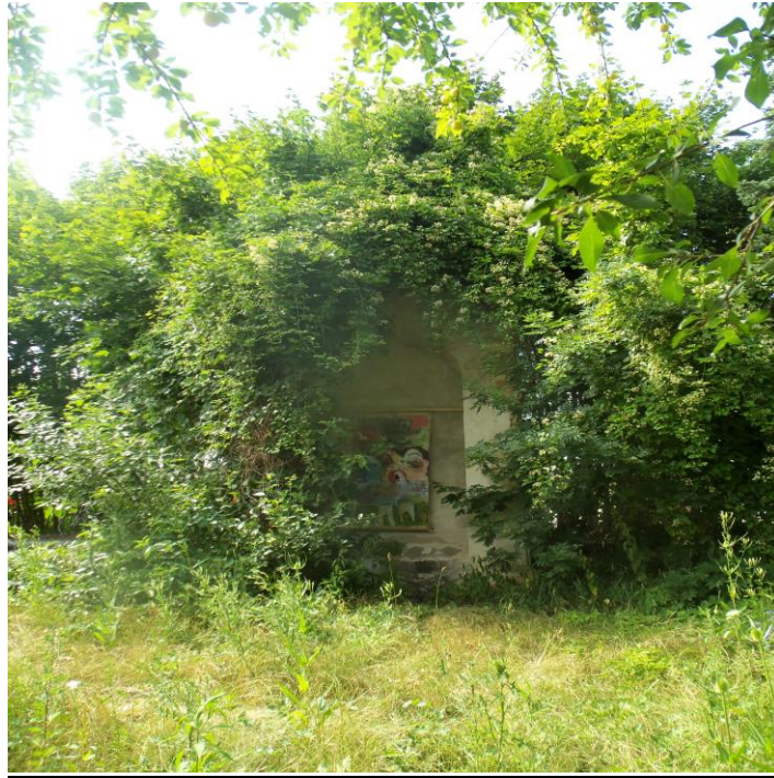
Hradopražská kaple v létě
