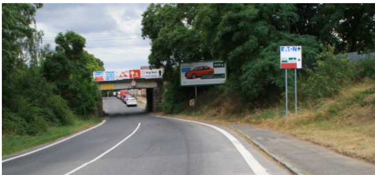
Podjezd pod železniční tratí v ul. Ve Žlíbku
