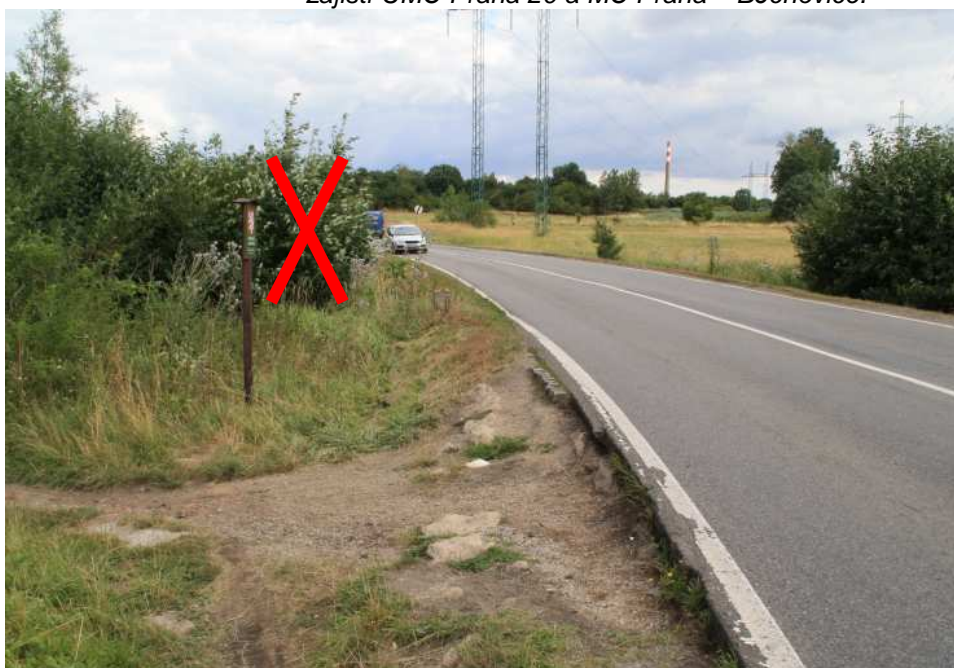
obr 1 - pohled od křížení severním směrem (ul. Ml. Běchovic - Ve Žlábku)
