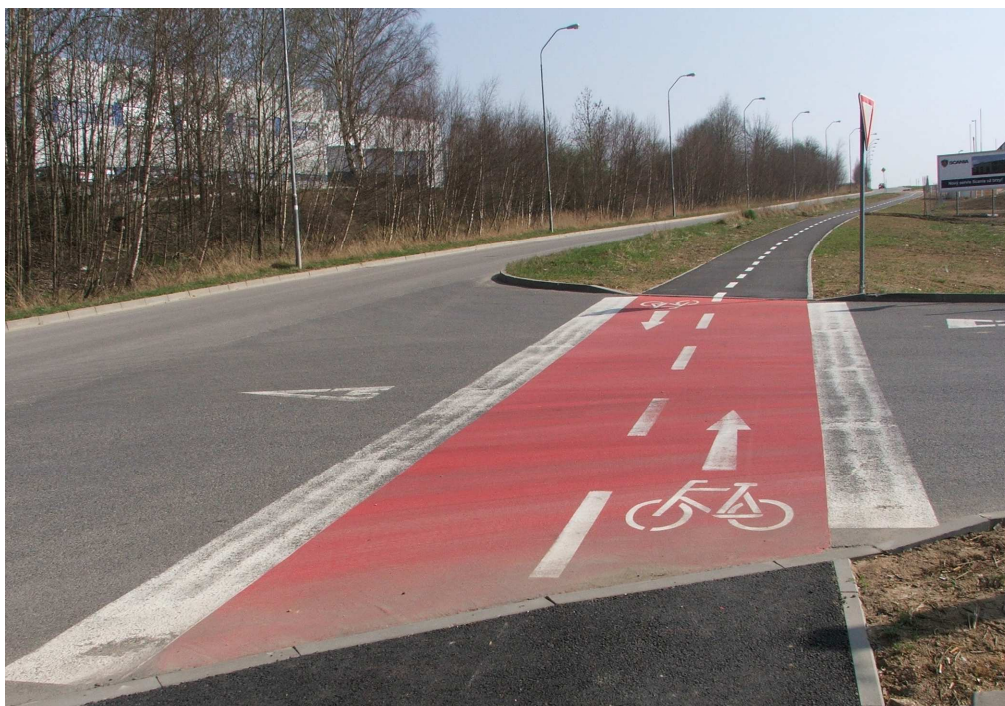
obr 3 - ukázka řešení výjezdu z obdobně využívaného průmyslového areálu z Jihlavy, kde se nepodařilo dořešit křížení stavebně, avšak ex-post pouze dopravním značením
