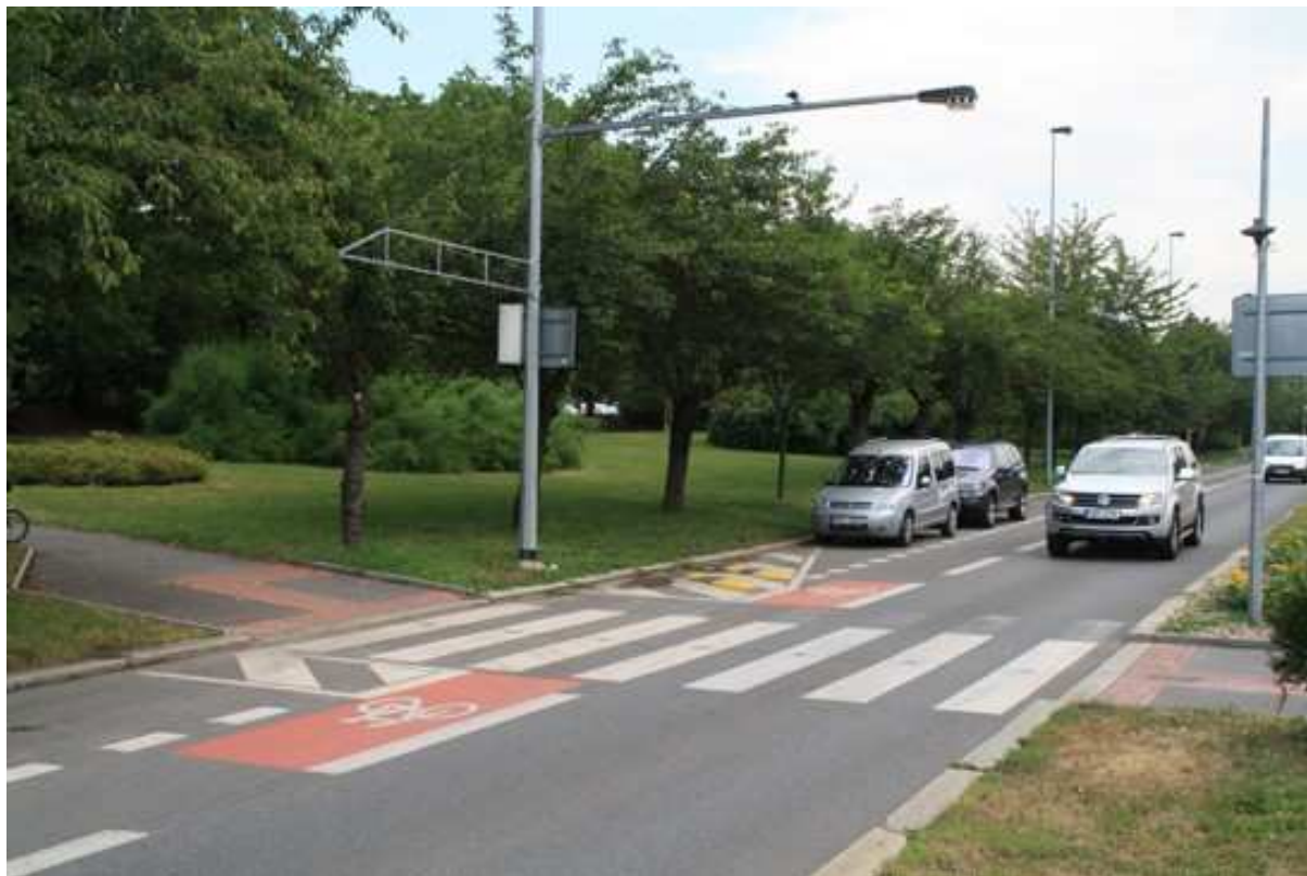
ilustrační foto – VJP místě přechodu pro chodce (ul. V Olšínách, Praha 10)
