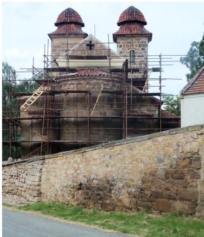
Bazilika v Tismicích procházela postupnou rekonstrukcí.
