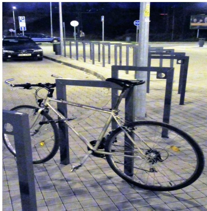
Obdobný typ stojanů např. před železničním nádražím v Berouně, ale hrany by zde neměly být.
