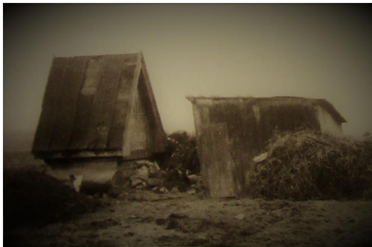
Zahradní budka A. Sedláčka již dlouho neexistuje, nyní jejím místem vede Dálnice č. 11.
