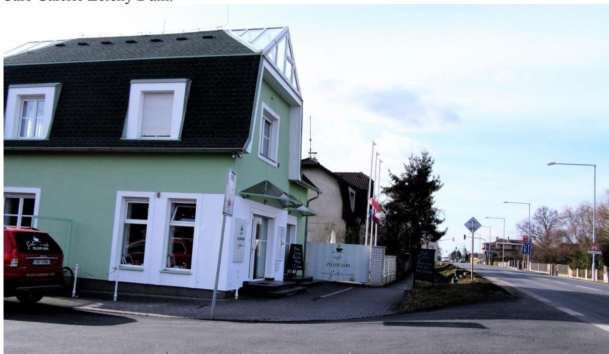
Zajímavě zrekonstruovaná Galerie je při hlavní silnici
