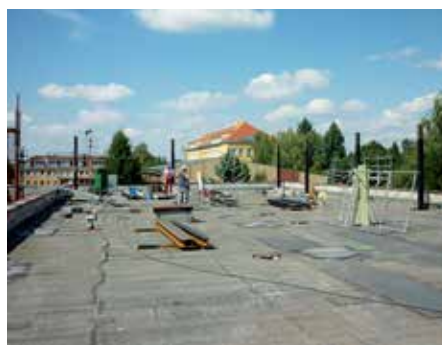
Budova MŠ Ratibořická bude mít nástavbu a zateplení.
