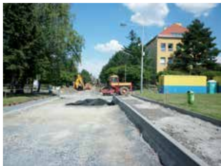
Ulice Jívanská u zastávky autobusu 223 během rekonstrukce
