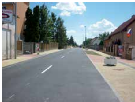
Nový povrch ulice Ve Žlábku
