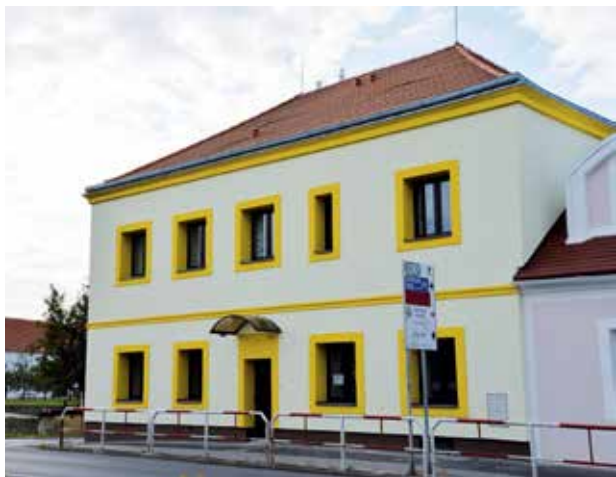
Dokončena je rekonstrukce domu č.p. 867 u vjezdu do areálu Chvalské tvrže.
