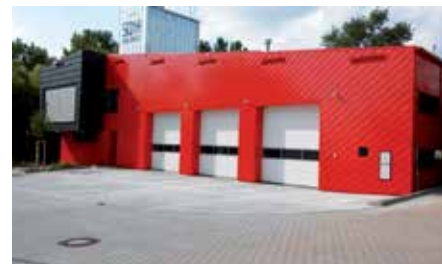
Nová budova zbrojnice SDH Běchovice
