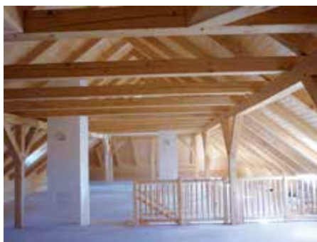
Půdní prostor v objektu č. 868/28 na Chvalech je zatím prázdný a čeká na nové využití.
