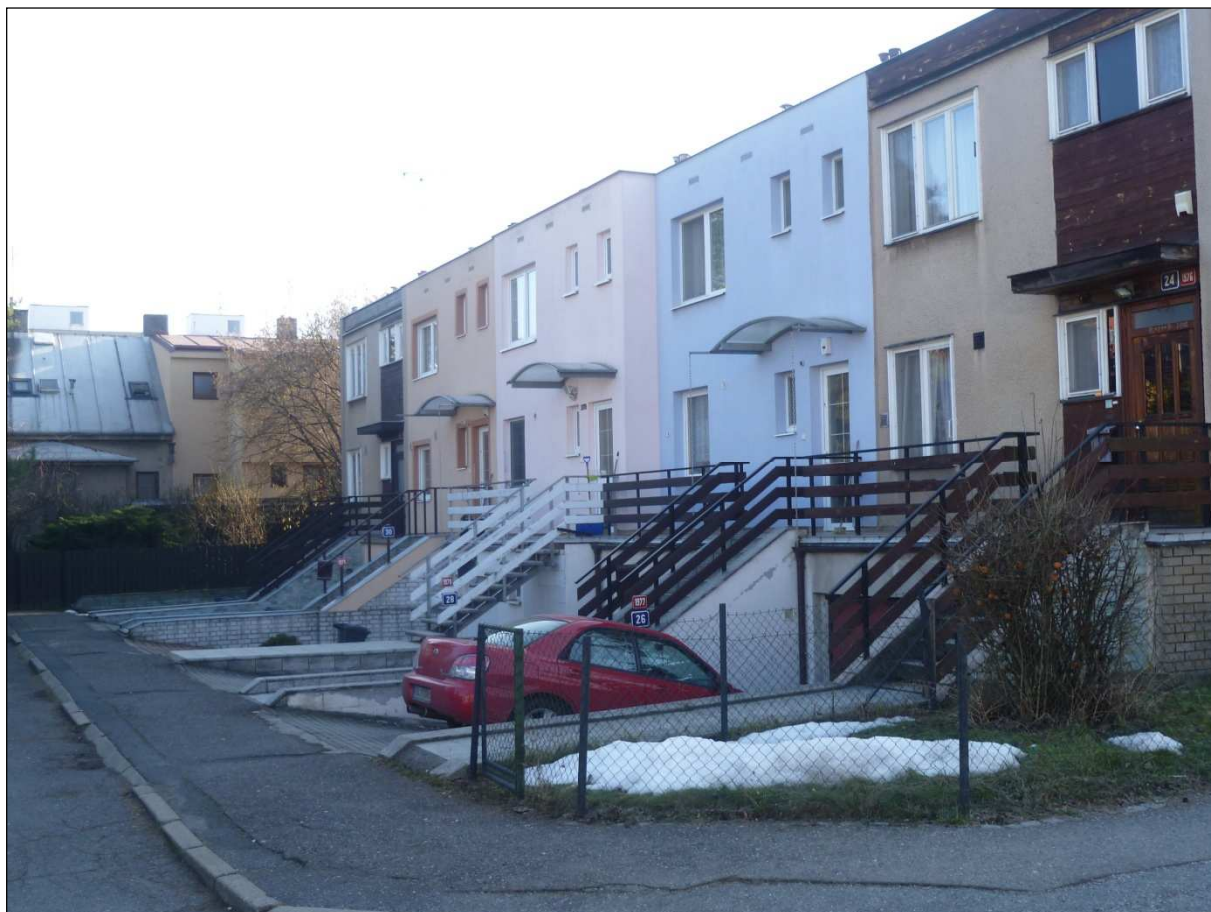
Obrázek č. 10 – řadové domy, ul. Běluňská
