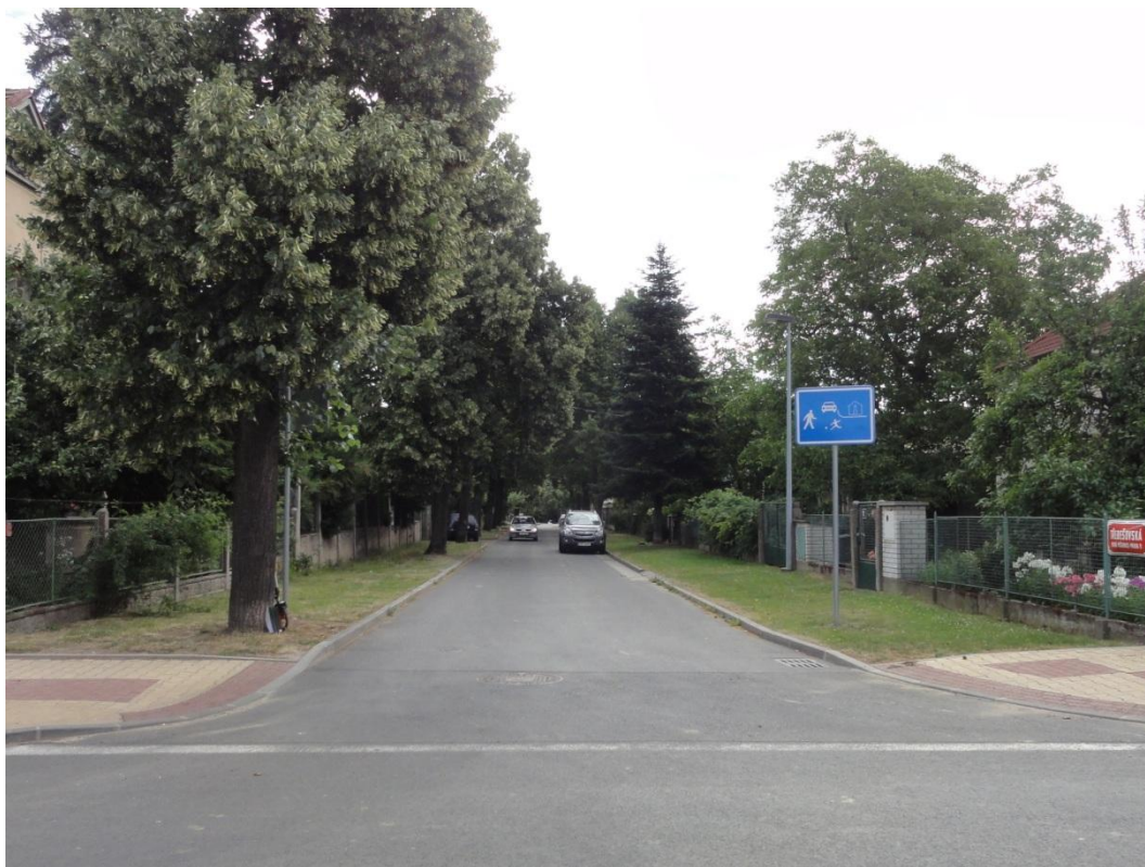
Obrázek 13. Část Třebešovské ulice nesplňující atributy obytné zóny. Zdroj: autor
