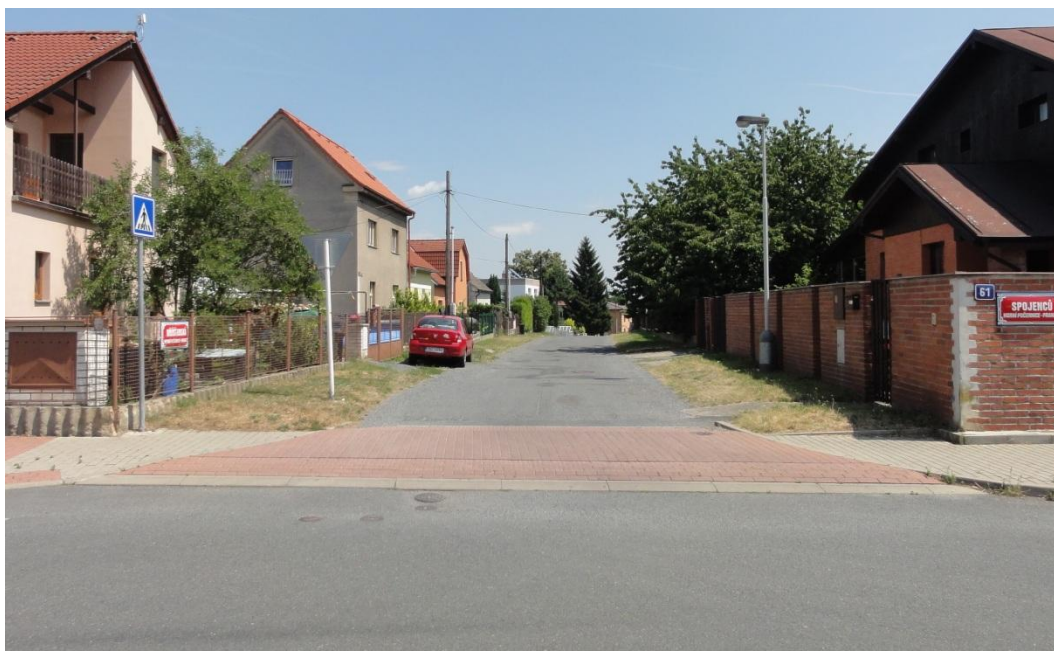
Obrázek 33. Lichoběžníkový dlouhý zpomalovací práh v Bříšťanské ulici. Zdroj: autor
