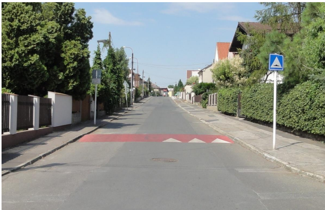
Obrázek 32. Kruhový dlouhý zpomalovací práh v Kramolné ulici. Zdroj: autor
