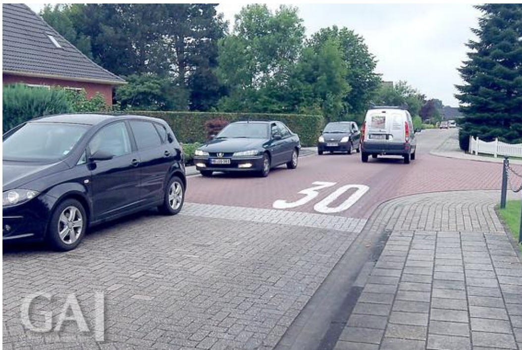
Obrázek 2. Zvýšená křižovatková plocha v zóně 30. Zdroj: http://www.ga-online.de/-news/artikel/101993/Hochbetrieb-in-der-Tempo-30-Zone
