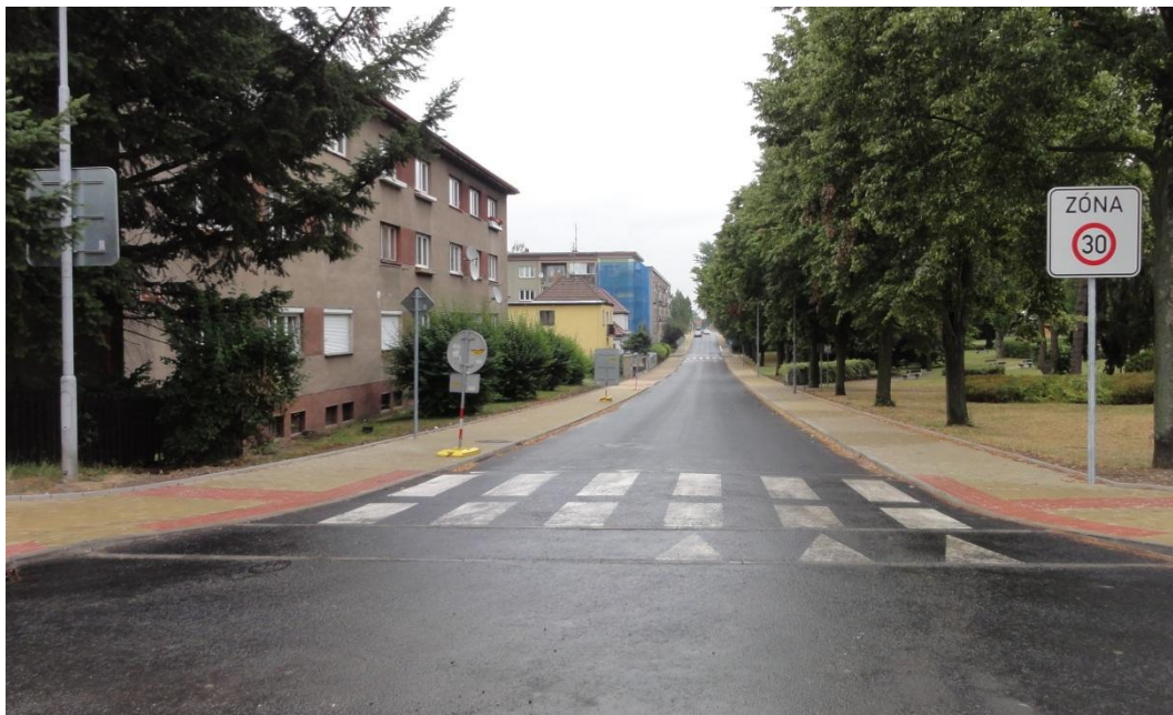
Obrázek 34. Dlouhý zpomalovací práh integrovaný s přechodem pro chodce na vjezdu do zóny 30 v Běluňské ulici. Zdroj: autor
