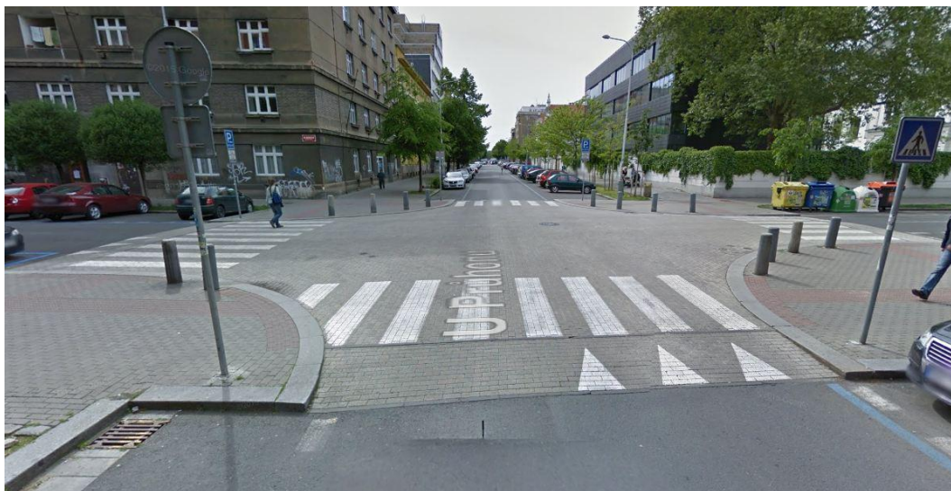
Obrázek 39. Zvýšená křižovatková plocha v Praze-Holešovicích. Zdroj: http://www.google.cz/maps/
