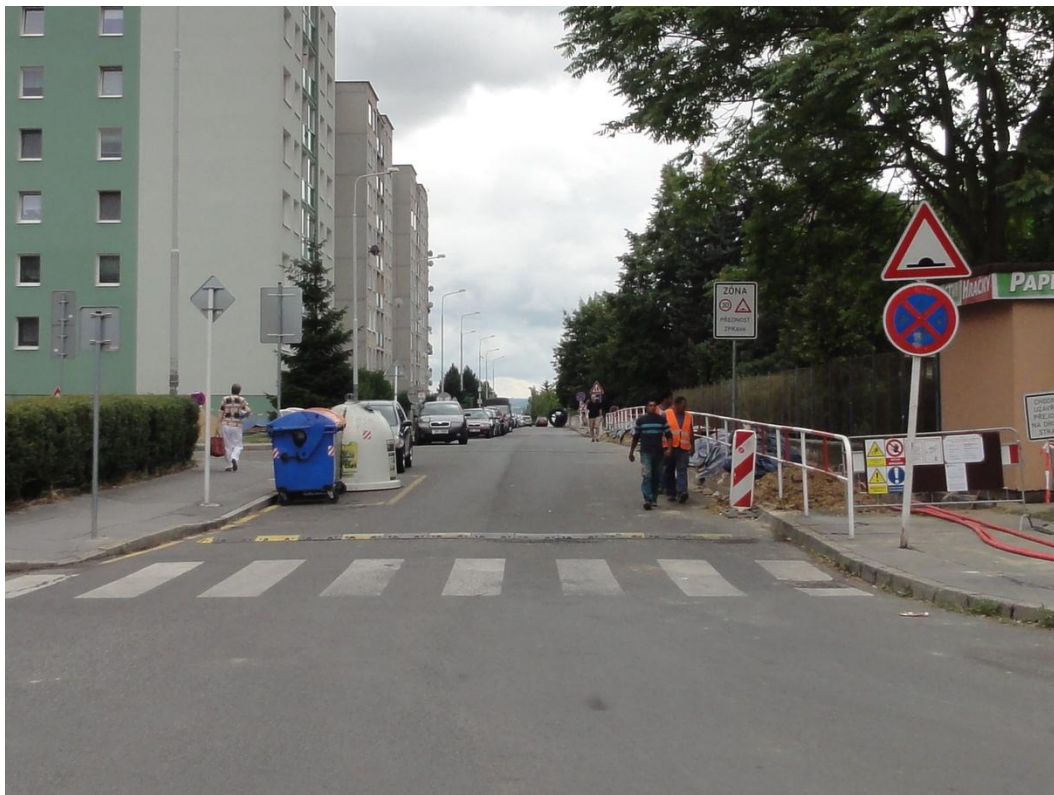
Obrázek 35. Krátký montovaný zpomalovací práh v Chodovické ulici. Zdroj: autor
