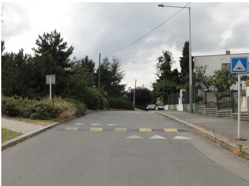
Obrázek 36. Trvalý krátký zpomalovací práh v Jeřické ulici. Zdroj: autor
