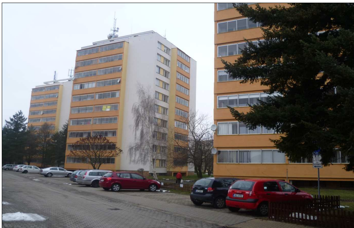
Obrázek č. 7 – první tři vícepodlažní panelové domy, ul. Ratibořická
