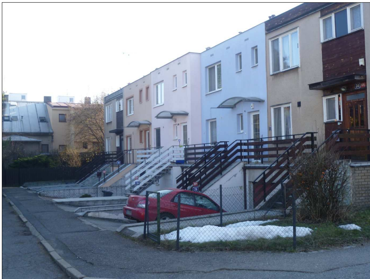
Obrázek č. 10 – řadové domy, ul. Běluňská
