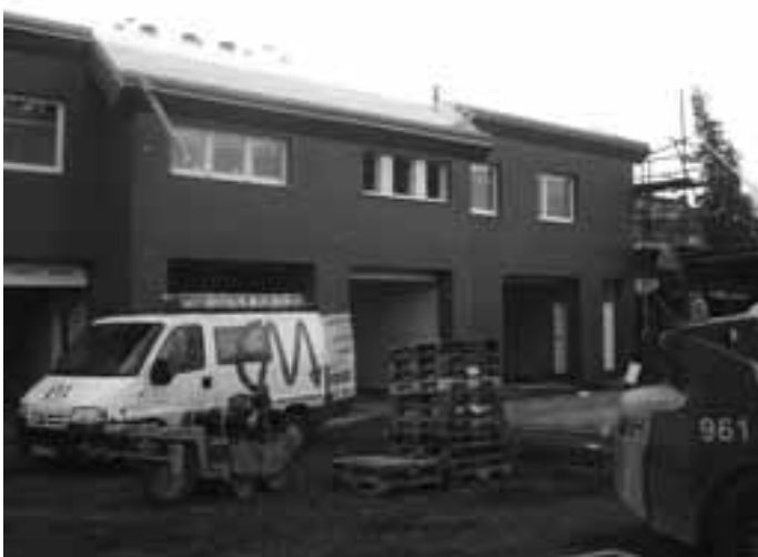
Nová budova místního hospodářství je před dokončením.
