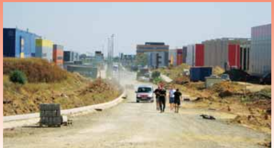
Ulice Do Čertouz těsně před dokončením na začátku srpna 2008
