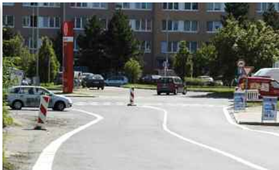
Pohled na právě zrekonstruované napojení ulic Bystrá - Náchodská
