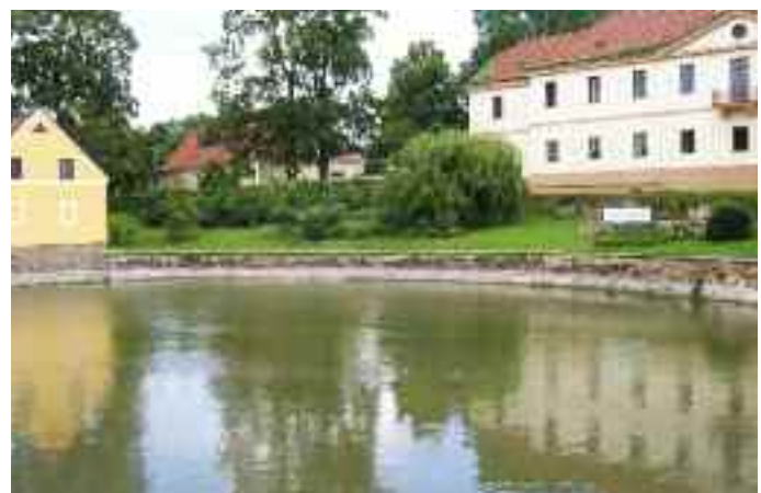
Oprava rybníka na Křovinově náměstí trvala šest týdnů.
