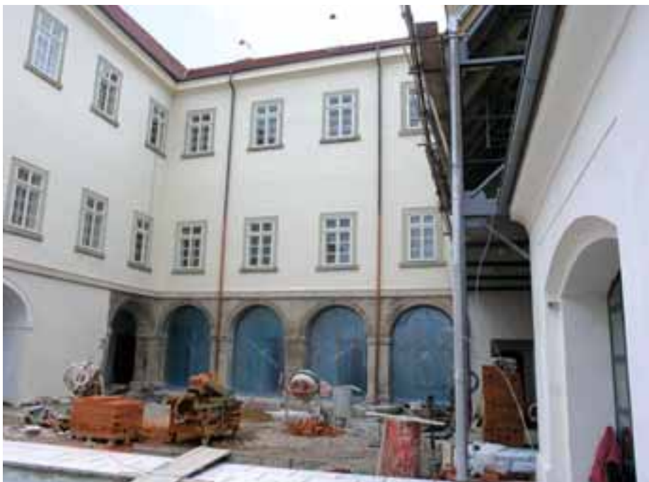
Celý zámek má od léta novou fasádu a okna.
