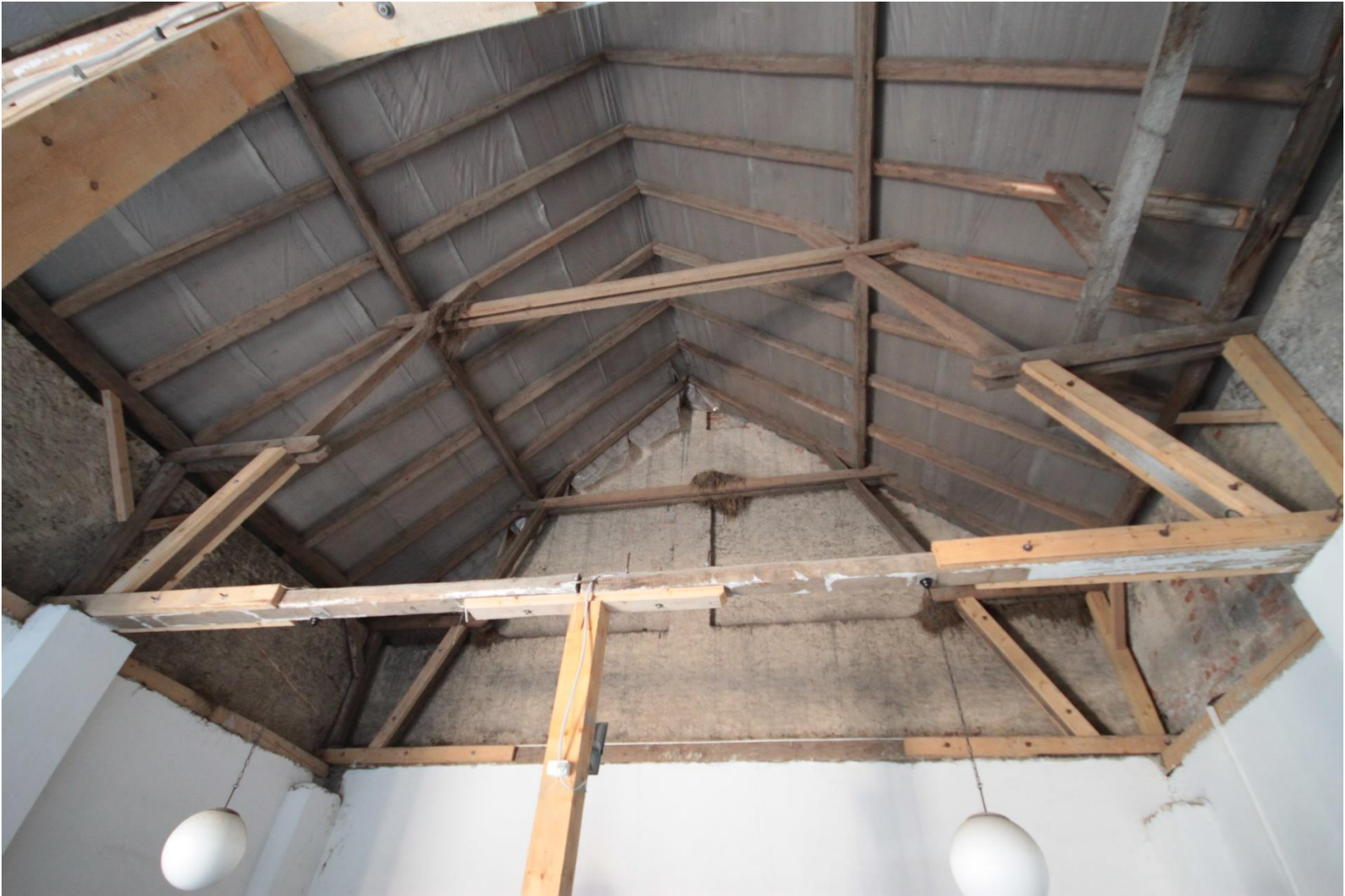
Pohled na štítovou zeď a novodobé doplňky krovu
