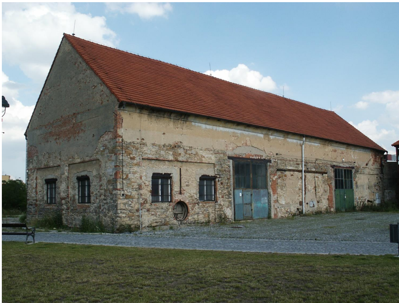
Celkový pohled od severozápadu z roku 2004
