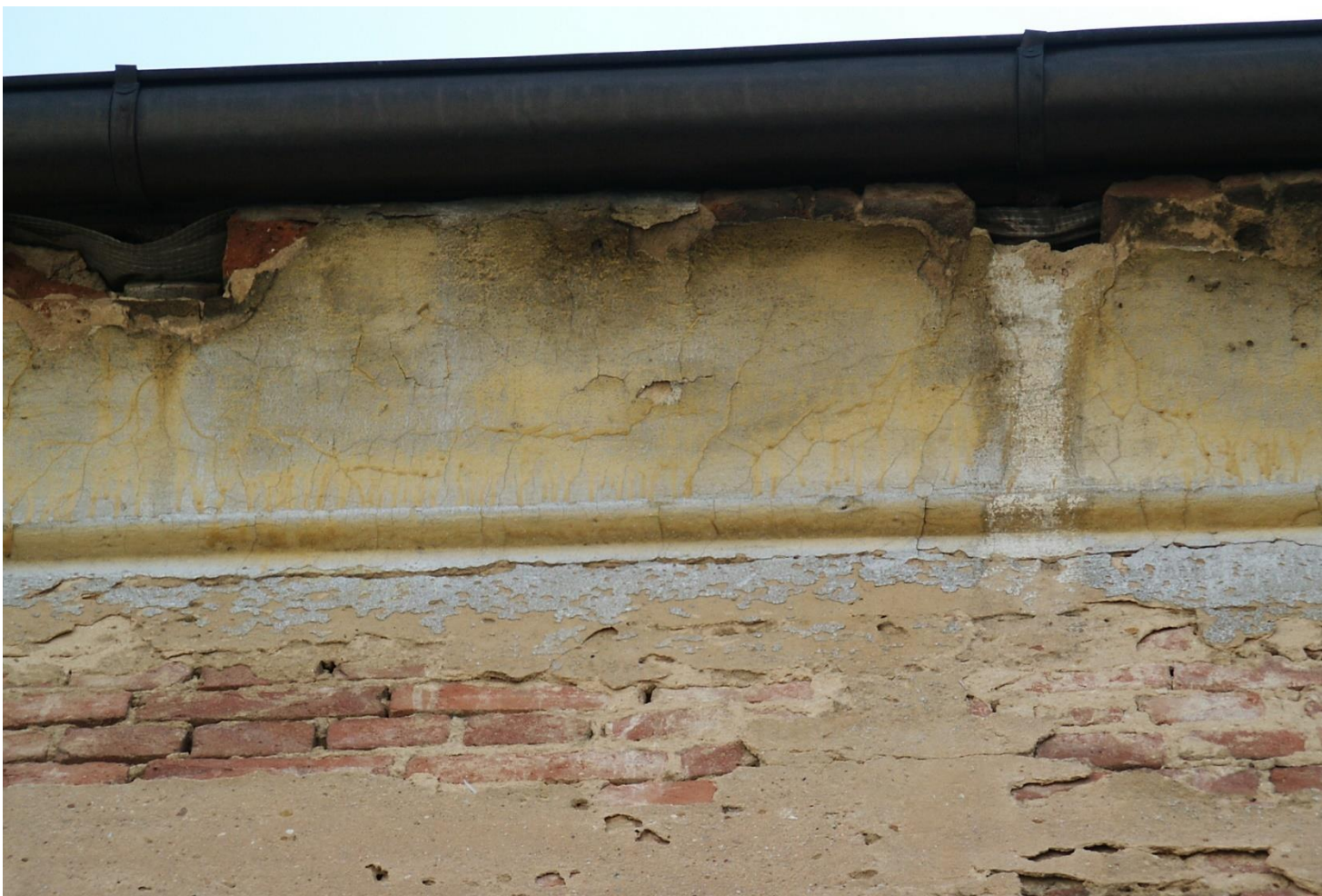
Detail římsy západního průčelí z roku 2004 se zbytky barevných nátěrů
