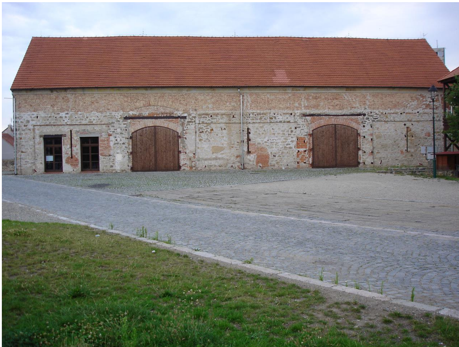
Pohled na západní průčelí v roce 2006
