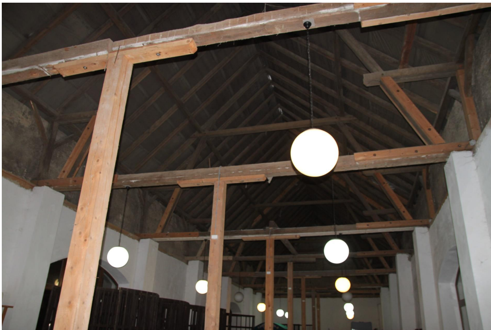
Celkový pohled do krovu
