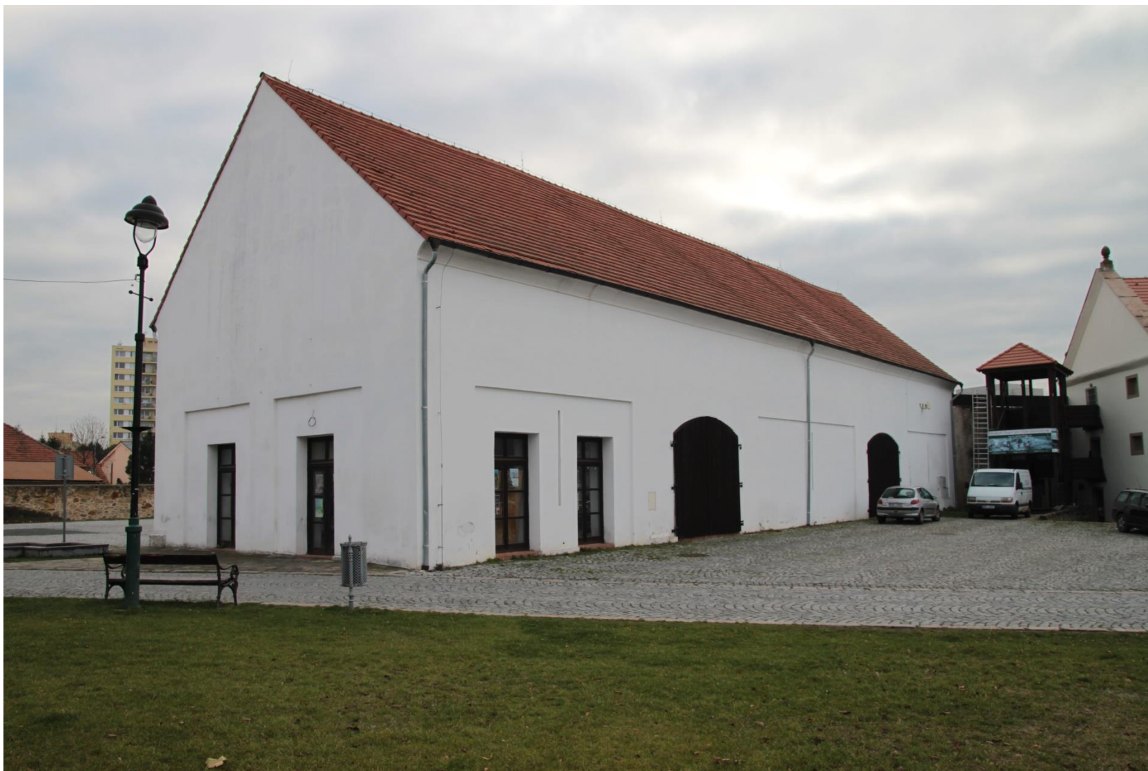
Celkový pohled od severozápadu
