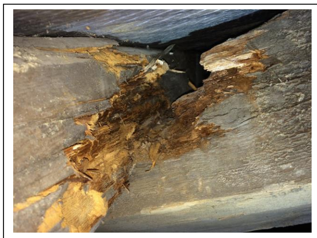
Foto 33 detail napadení středové vaznice
