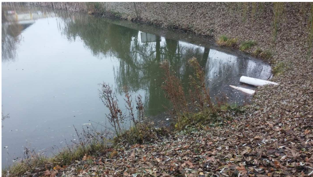
Obr. 24 – Vyústění 1 x DN 400 + 1 x DN 200
