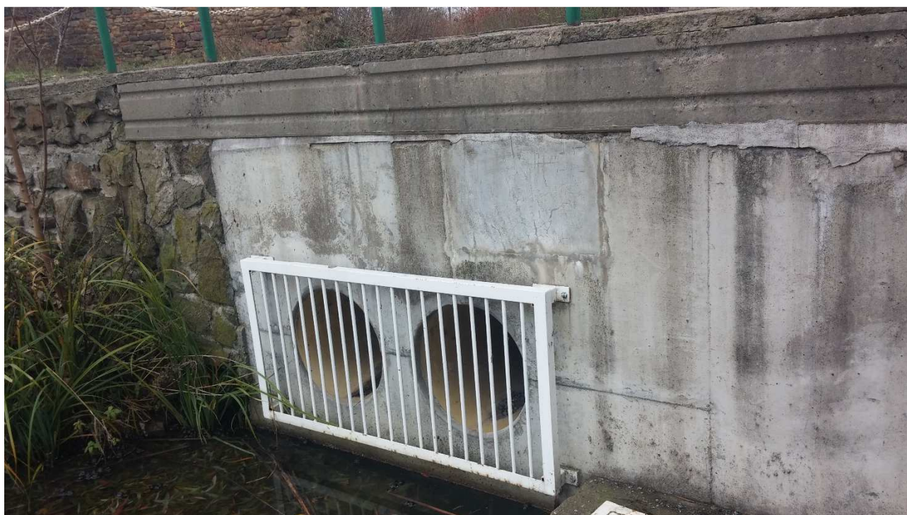
Obr. 6 – Celkový pohled na bezpečnostní přelivy s mostovkou
