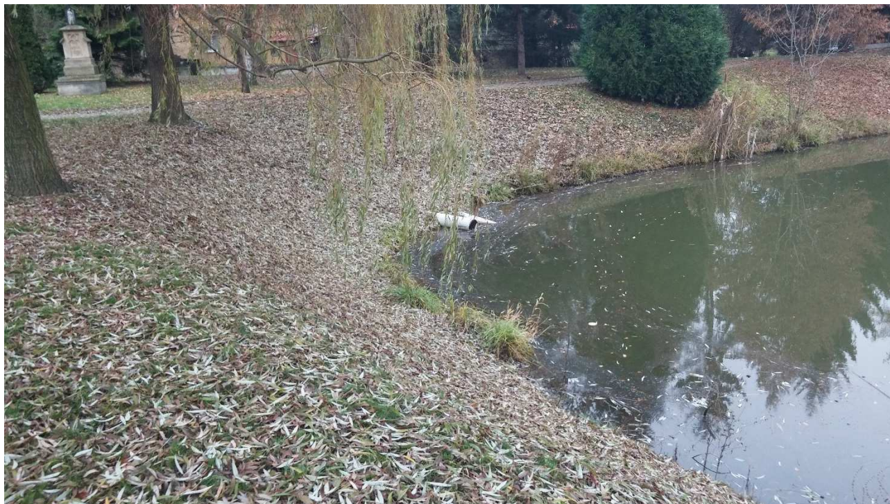
Obr. 23 – Vyústění 1 x DN 400 + 1 x DN 200
