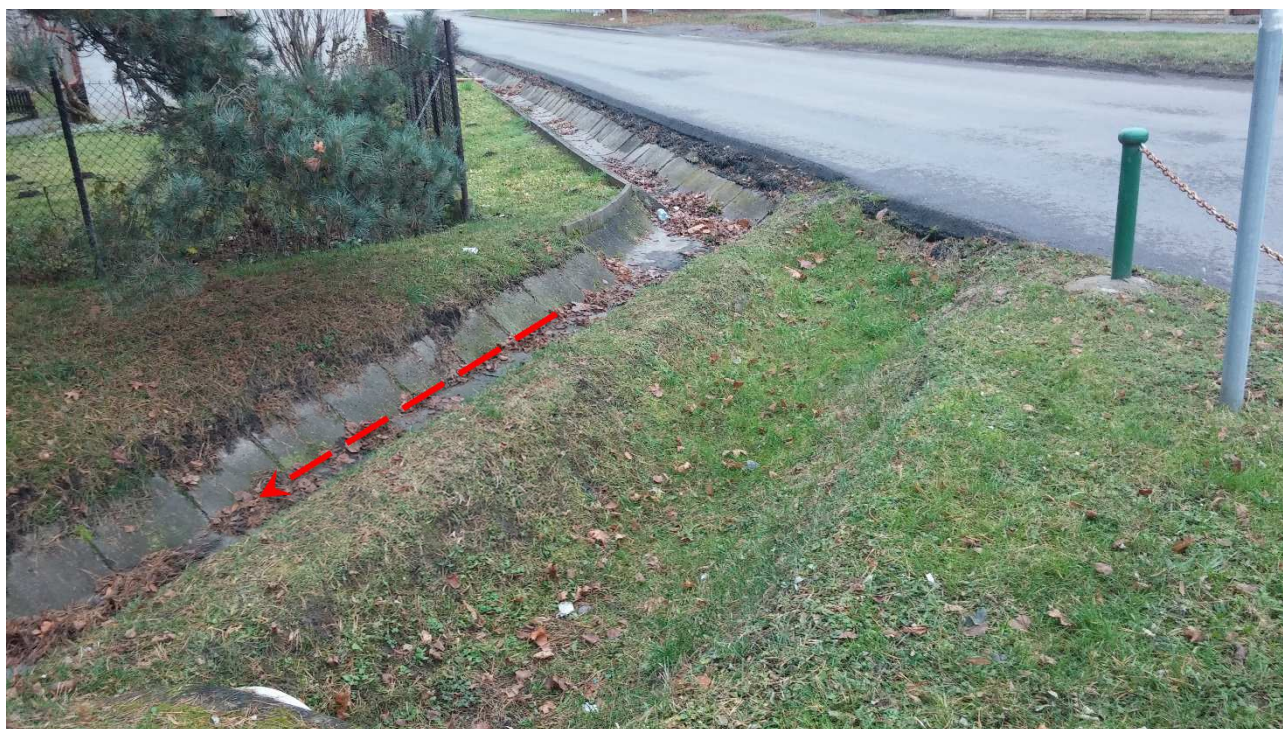
Obr. 31 – Povrchového odvodnění v ul. Bártlova
