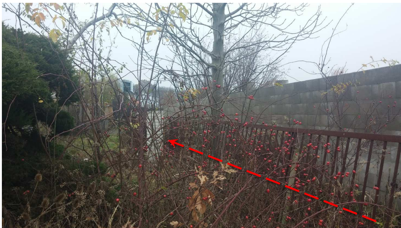
Obr. 19 – Zatrubněné koryto vodoteče mezi oploceními
