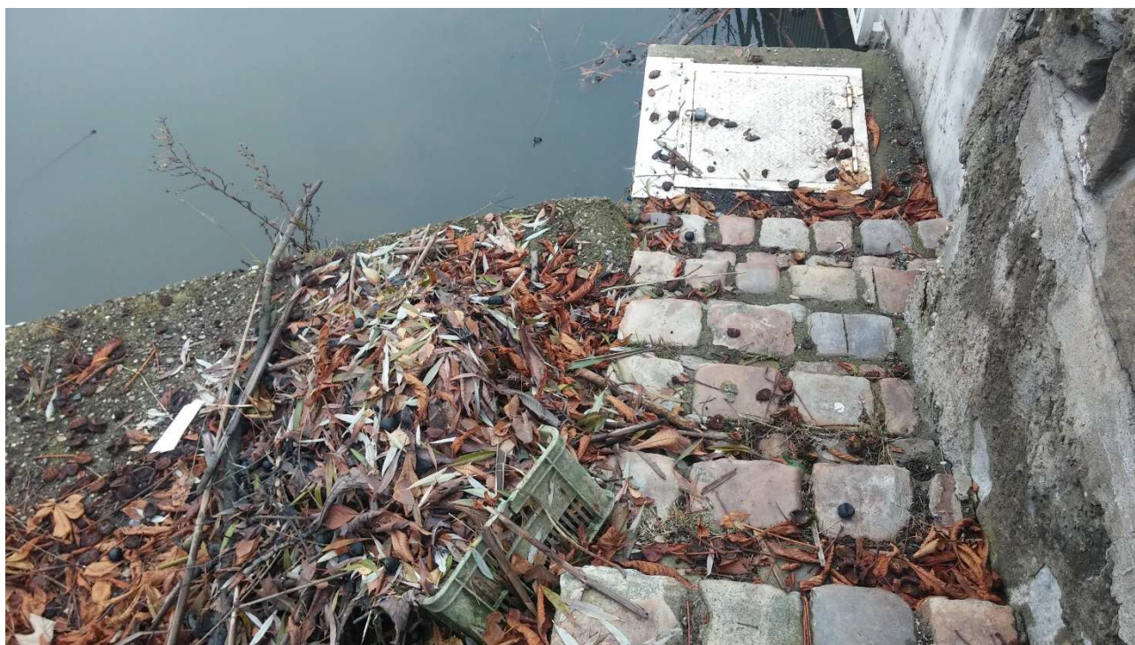
Obr. 5 – Schodiště k požeráku
