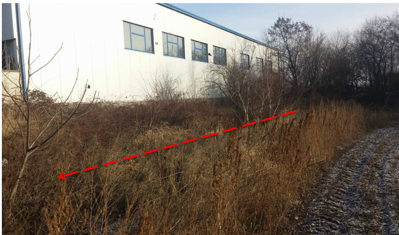
Obr. 14 – Zanešené koryto vodoteče podél areálu Iveco
