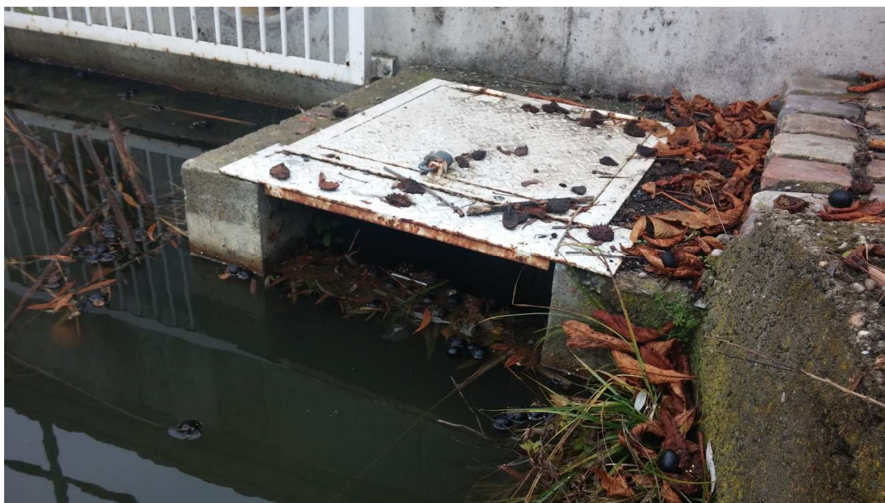
Obr. 4 – Detailní pohled na zanešenou dlužovou hranu
