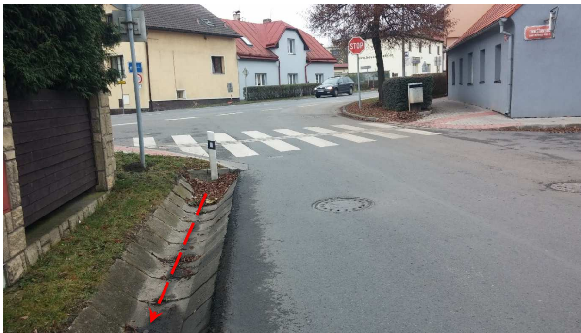
Obr. 26 – Začátek povrchového odvodnění (křižovatka Bártlova / Náchodská / Ohnišťanská)
