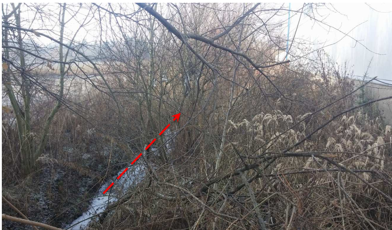
Obr. 13 – Zanešené koryto vodoteče podél areálu Iveco
