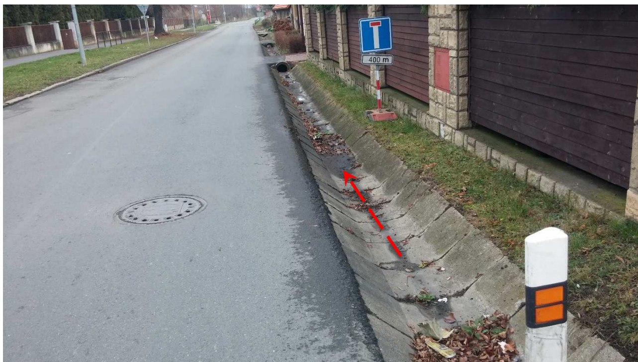
Obr. 27 – Povrchového odvodnění v ul. Bártlova
