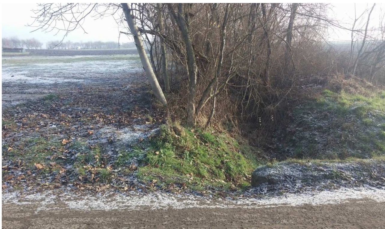
Obr. 10 – Pohled z ulice Bořetická východním směrem v místě propustku
