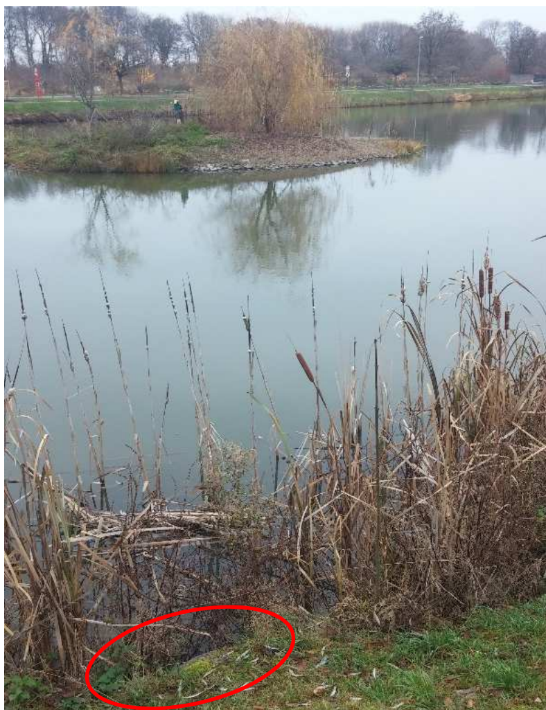
Obr. 21 – Vyústění zatrubněné vodoteče do jižního břehu rybníka
