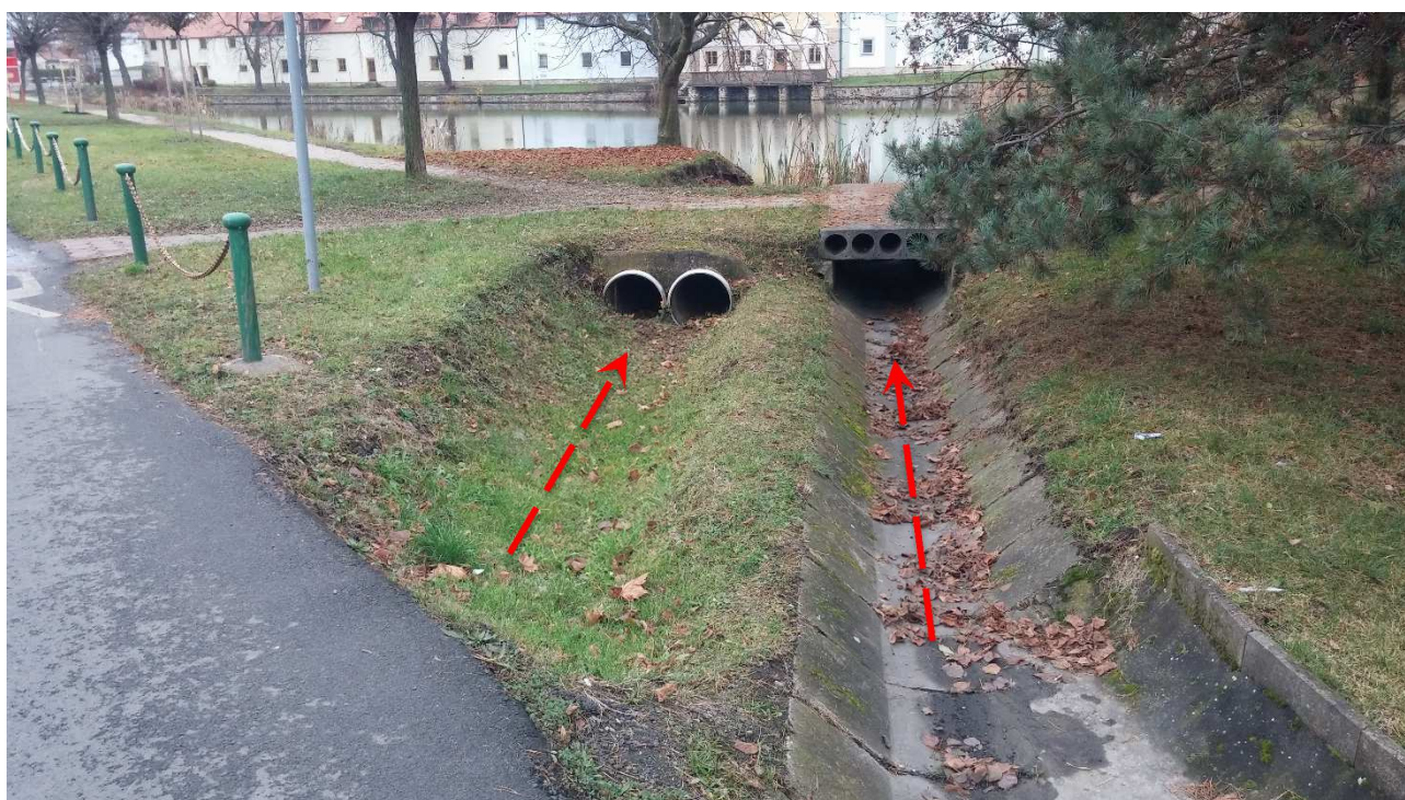
Obr. 32 – Povrchového odvodnění v ul. Bártlova
