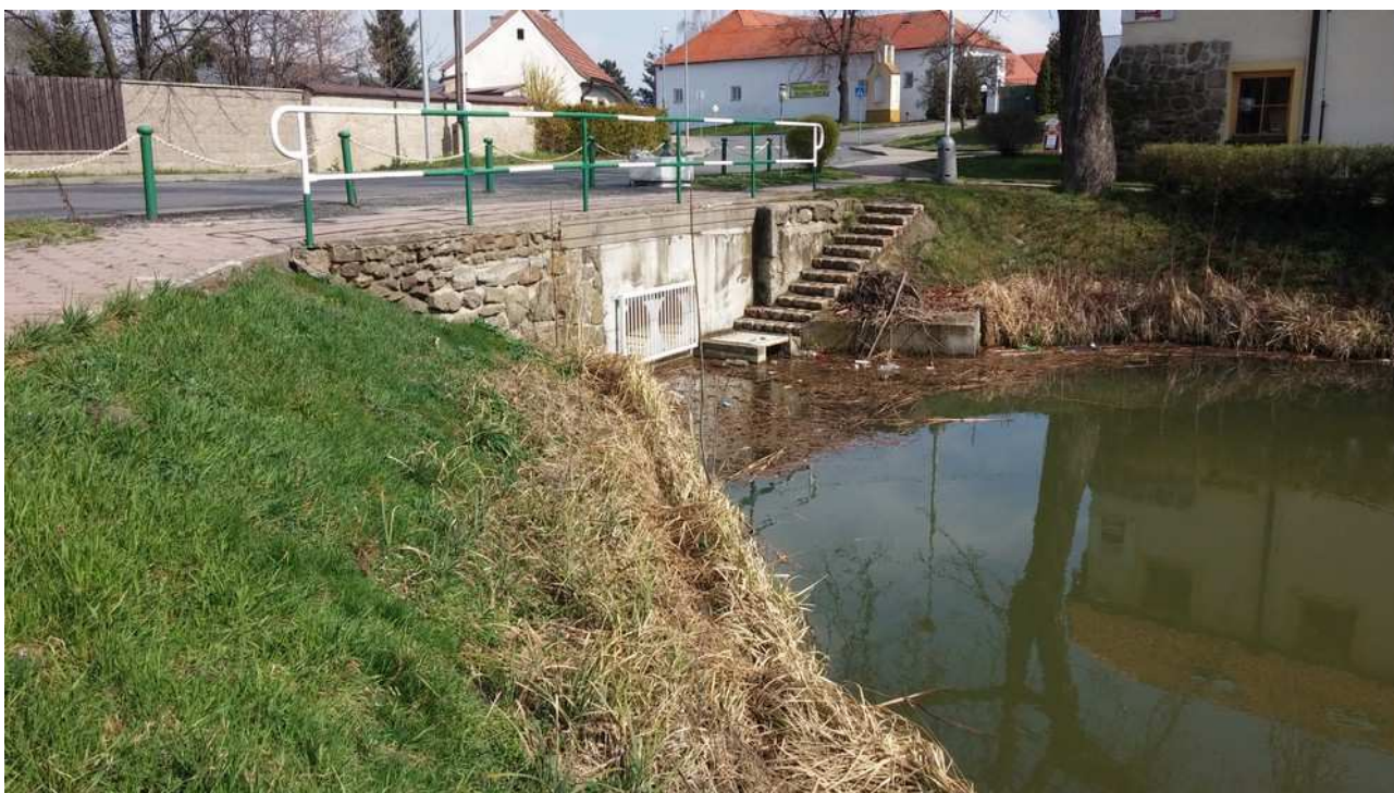
Obr. 2 – Podhled na výustní objekt
