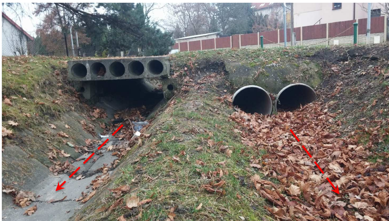
Obr. 33 – Povrchového odvodnění v ul. Bártlova
