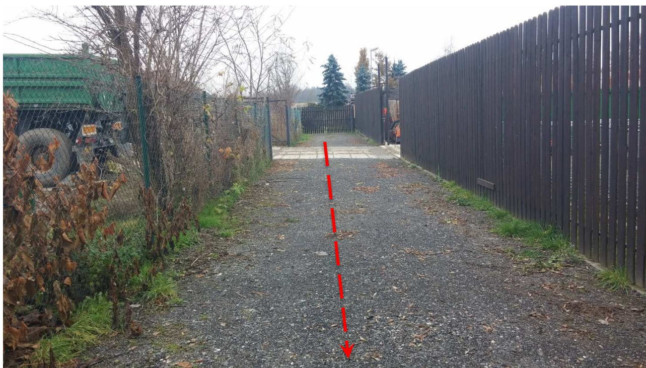
Obr. 20 – Zatrubnění vodoteče jižně od ul. Náchodská
