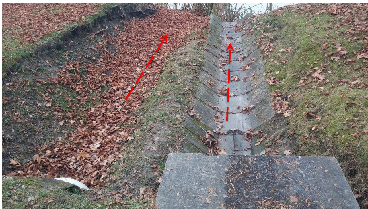
Obr. 34 – Vyústění povrchového odvodnění v ul. Bártlova
