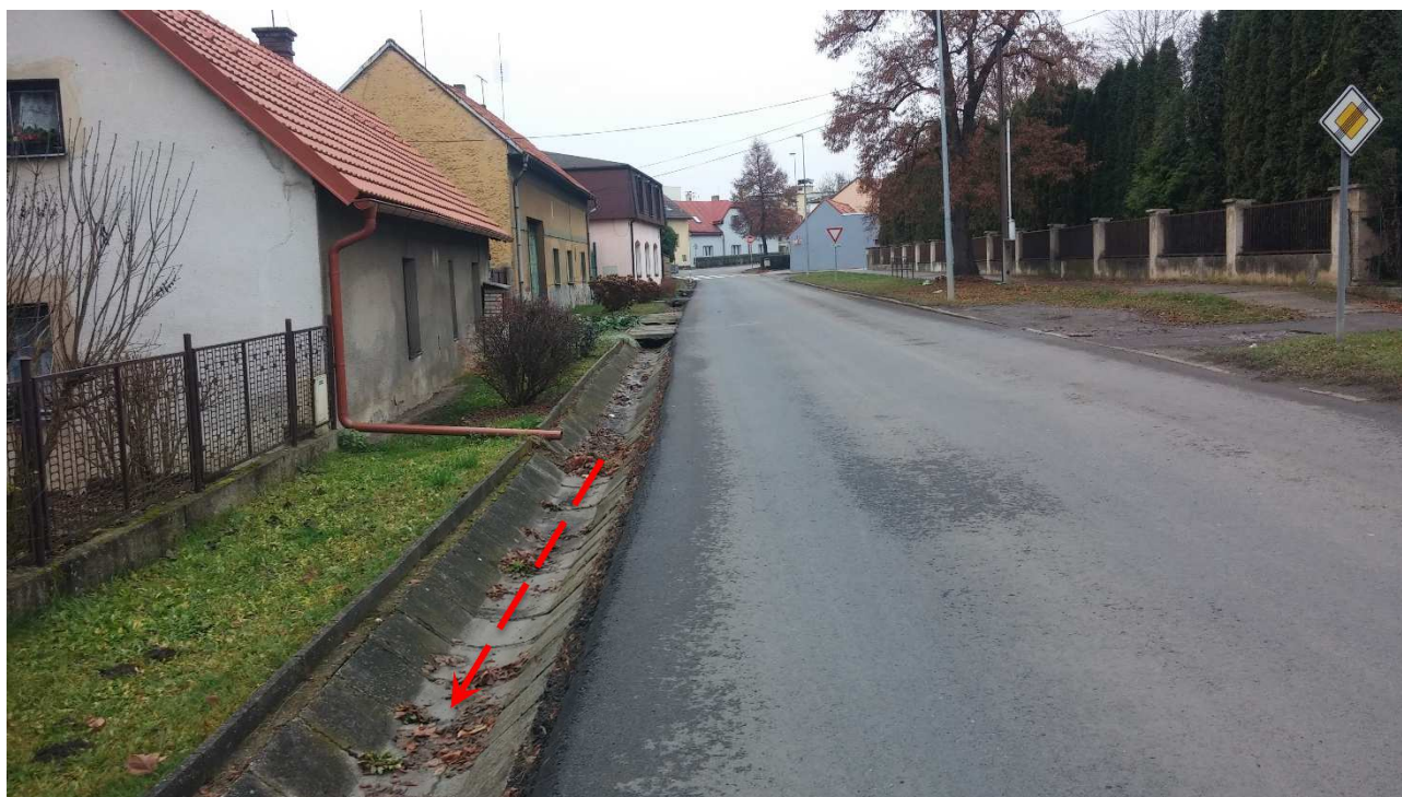
Obr. 29 – Povrchového odvodnění v ul. Bártlova
