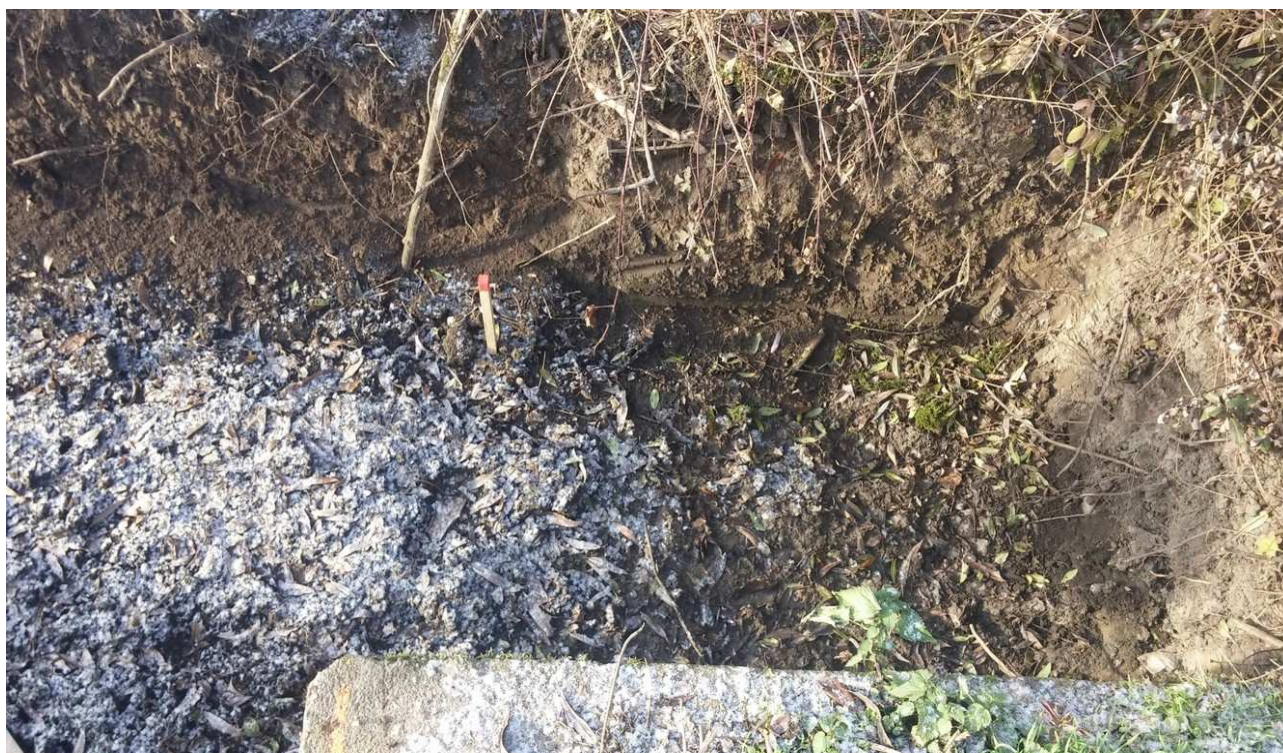
Obr. 11 – Pohled z ulice Bořetická západním směrem v místě propustku (zleva přítok budovaného žlabu)
