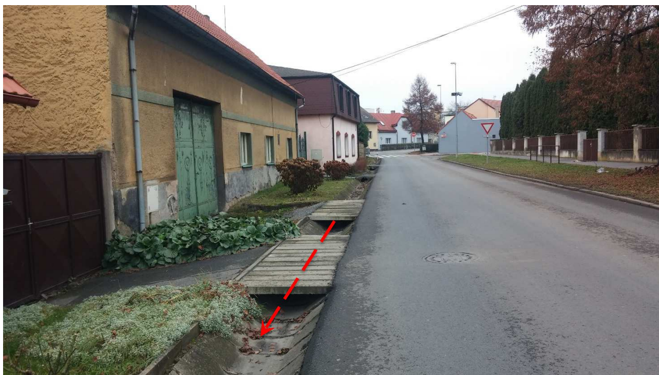
Obr. 28 – Povrchového odvodnění v ul. Bártlova
