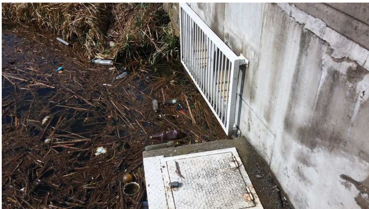
Obr. 3 – Pohled na uzamykatelný poklop požeráku, v pozadí pevné česle bezpečnostních přelivů
