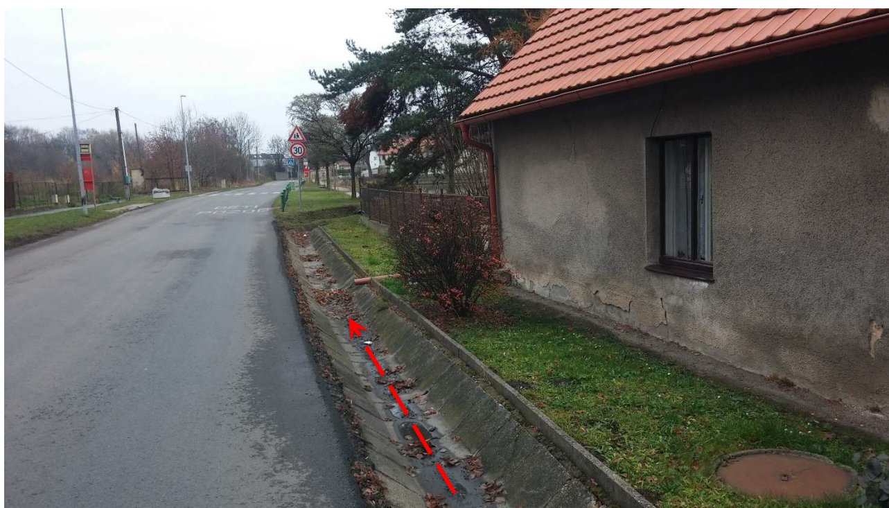
Obr. 30 – Povrchového odvodnění v ul. Bártlova
