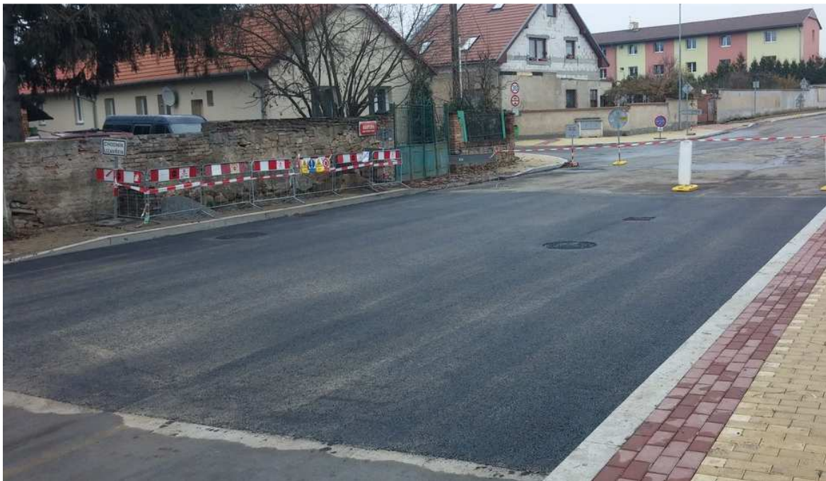
Obr. 3 – Úprava komunikace po výměně stropních desek objektů O4 a O5
