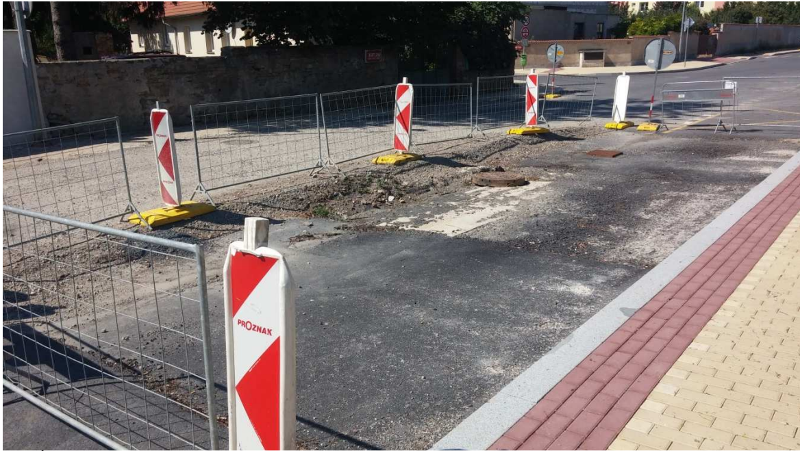
Obr. 2 – Úprava komunikace po výměně stropních desek objektů O4 a O5
