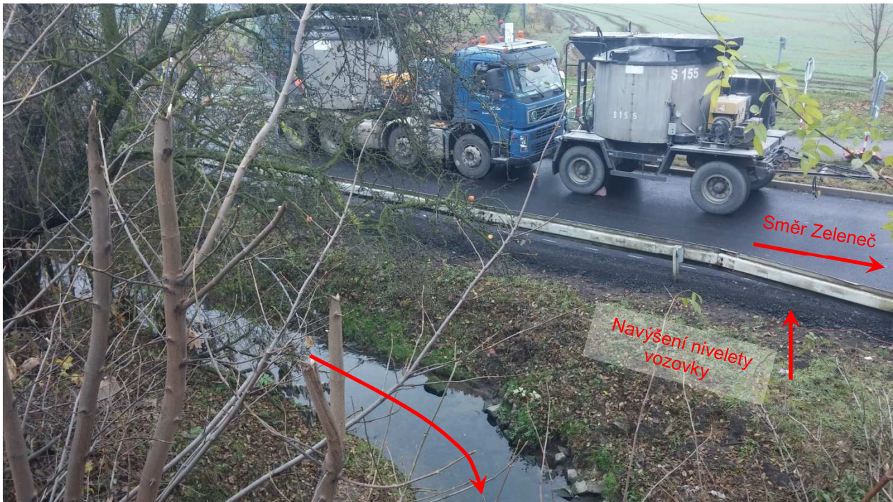
Obr. 4 – Pohled z portálu objektu O8 a silnici 10162 (22.11.2016)
