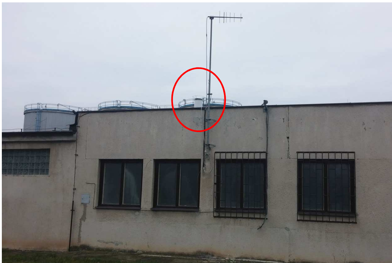
Obr. 3 Umístění srážkoměru S1 na střeše budovy č. p.2456 v areálu PČOV Čertousy
