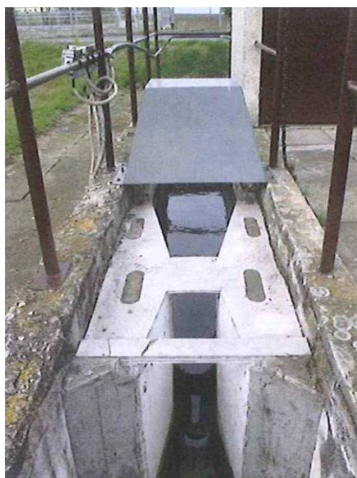
Obr. 7 Měrný profil MP3 - Umístění sondy US 1200 nad Parshallovým žlabem
