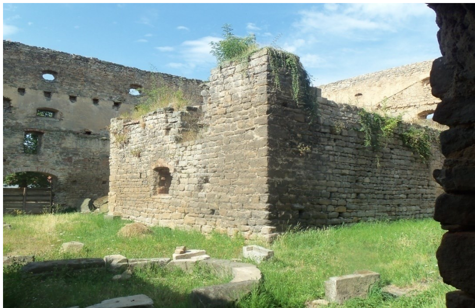
Vyšehořovická tvrz je rozsáhlá
