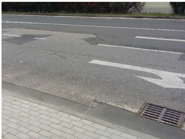
Foto č. 3: Nerovnosti povrchu silnice a hlučný kanalizační poklop mezi křižovatkami ul. Božanovská a Bystrá – detail
