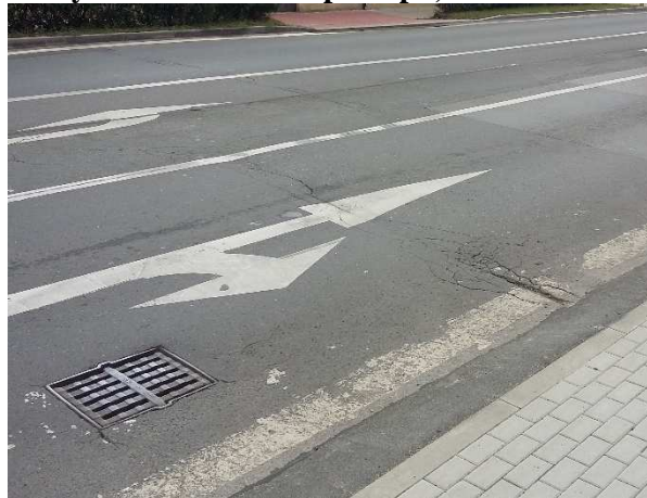
Foto č. 2: Trhliny a nerovnosti povrchu silnice a hlučný kanalizační poklop v okolí křižovatky ul. Božanovská a Náchodská – detail
