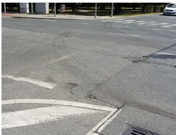
Foto č. 4: Trhliny a výtlučky na povrchu silnice na křižovatce s ul. Ve Žlíbku – detail
