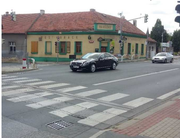
Foto č. 1: Trhliny a nerovnosti povrchu silnice a hlučný kanalizační poklop na křižovatce ul. Božanovská a Náchodská
