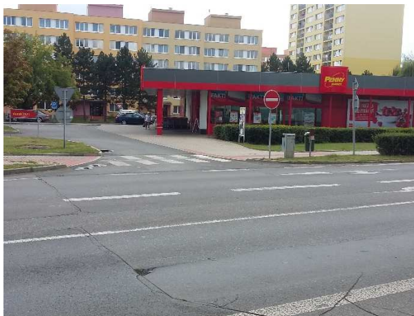
Foto č. 4: Trhliny a výtluk na povrchu silnice v okolí křižovatky ul. Bystrá a Náchodská
