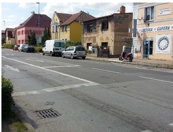
Foto č. 3: Hlučný kanalizační poklop na křižovatce s ul. Ve Žlíbku
