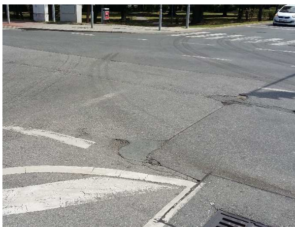
Foto č. 4: Trhliny a výtlučky na povrchu silnice na křižovatce s ul. Ve Žlábku – detail
