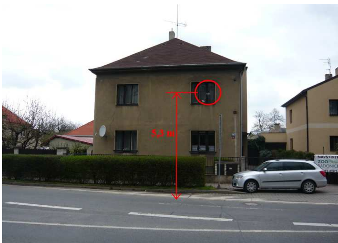
Obr. 5: Pohled na místo měření M2
