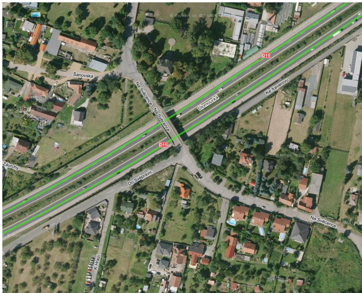
Poslední překážka brání opravě mostu přes dálnici D11, neznámý majitel stavby, právě padla
