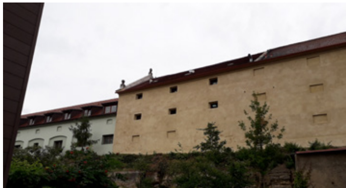
Špýchar před (vlevo): opadaná fasáda, vztlínající voda, zničená okapní římsa. Špýchar po opravě (vpravo): nová fasáda s okapní římsou a systémem ochrany před dešťovou i zemní vodou
