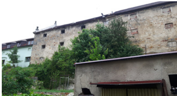
Špýchar před (vlevo): opadaná fasáda, vztlínající voda, zničená okapní římsa. Špýchar po opravě (vpravo): nová fasáda s okapní římsou a systémem ochrany před dešťovou i zemní vodou
