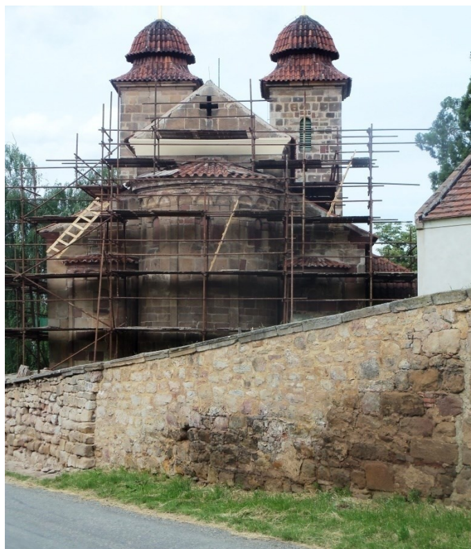
Bazilika v Tismicích, když procházela rekonstrukcí.
