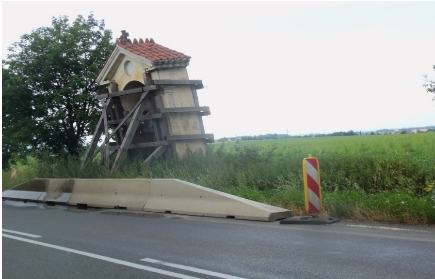
Kaplička mezi Brandýsem a Dřevčicemi u hlavní silnice č. 610.
