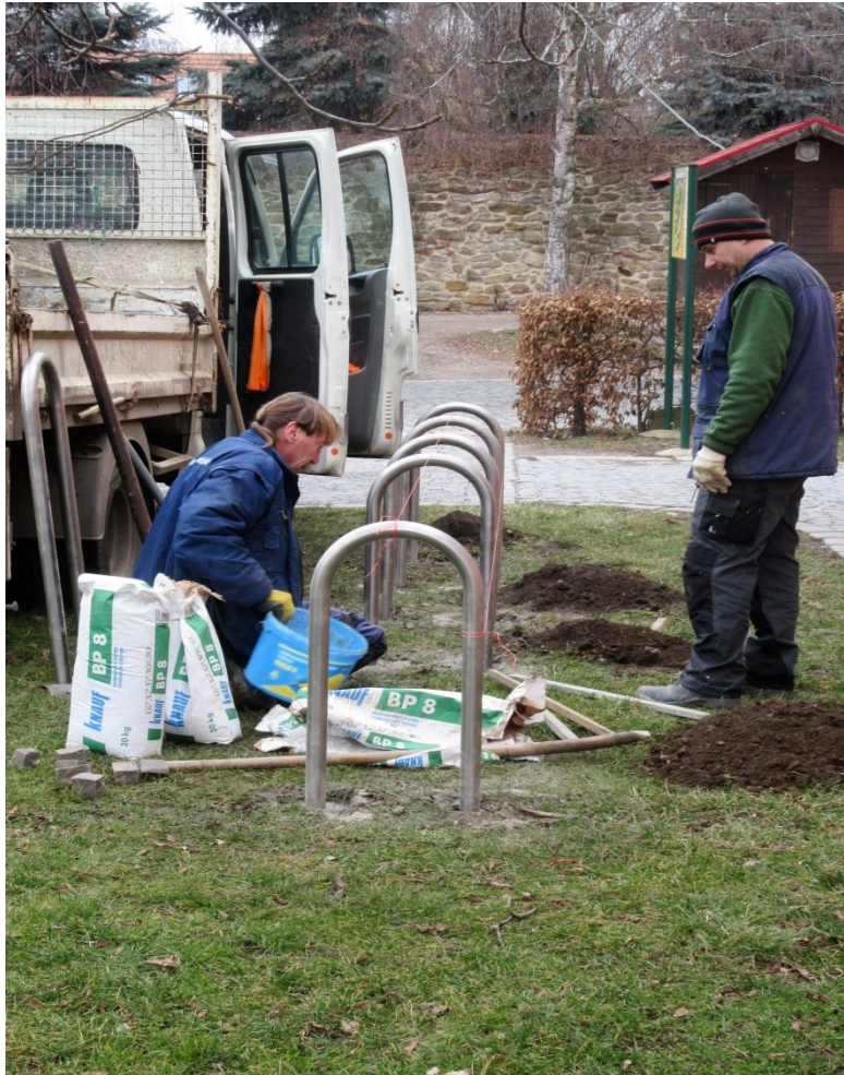
Instalace nových cyklostojanů v areálu Chvaly.
