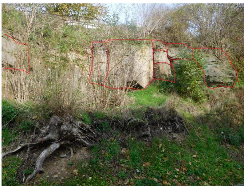
Foto č. 7: horninové bloky postihnuté překlápěním, naznačení směru a sklonu diskontinuit nejkritičtějších částí masivu
