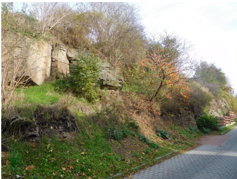
Foto č. 6: zájmová oblast staničení cca km 0,043 – km 0,051; lze vidět silné zanesení sprašemi spolu s kořenovým systémem náletové vegetace
