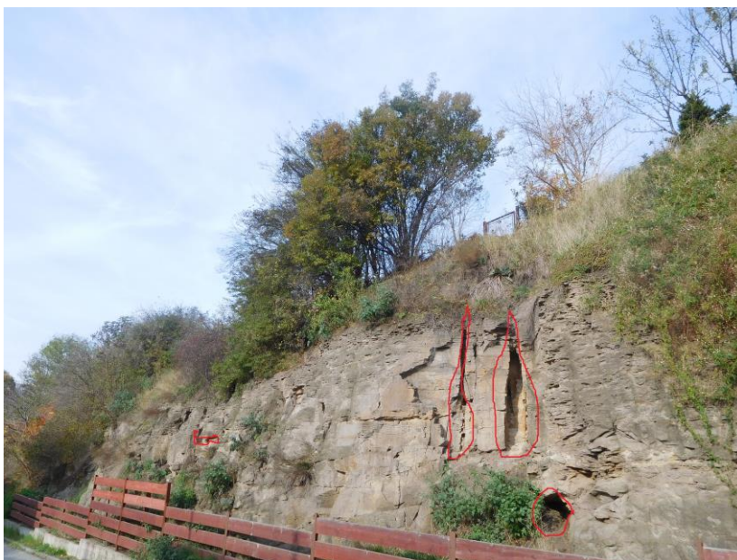
Foto č. 11: místa vhodného zaplombování širších horninových puklin
