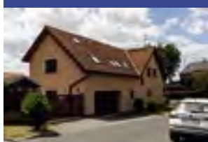
Třigenerační rodinný dům Spojenců, Horní Počernice
