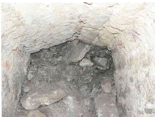
Anglický dvorek do sklepa pod ordinací je zasypán sutí a brání větrání.
