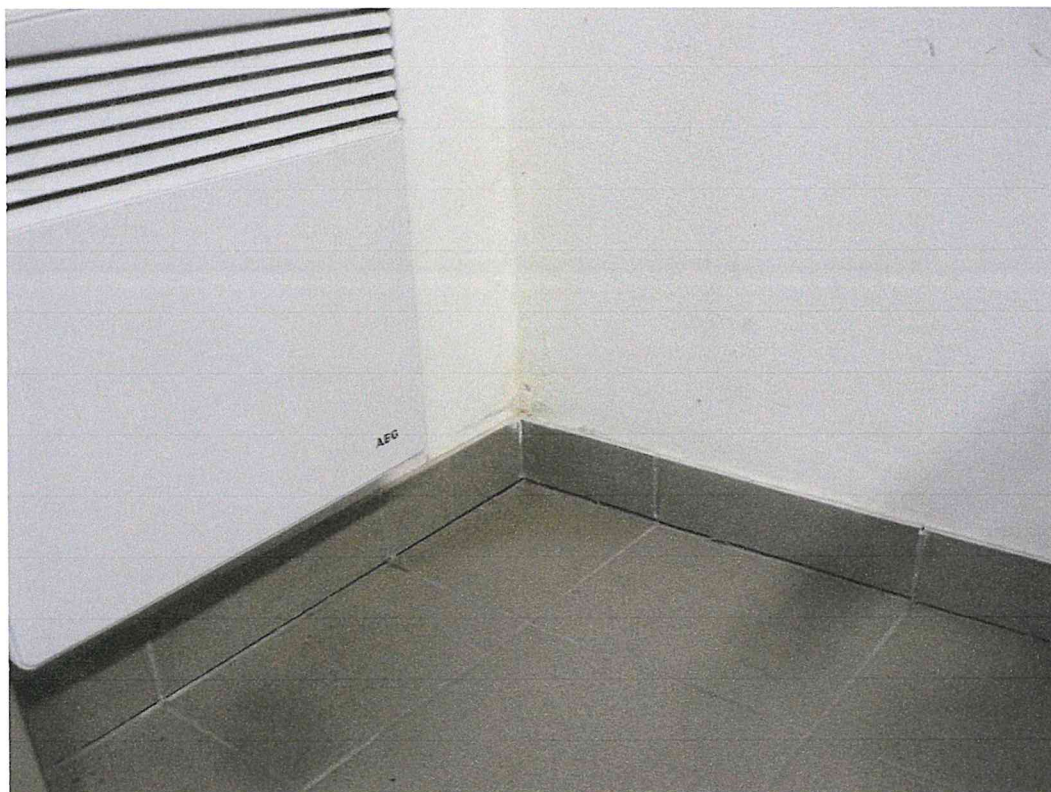
Propadlá podlaha u stěny provozovny Zdravotní pomůcky s příčnou prasklinou.
