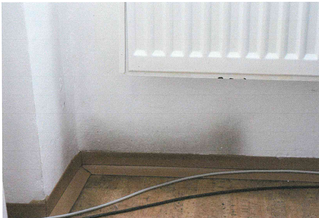
Plíseň na stěně ordinace praktické lékařky MUDr. Jany Bruothové.
