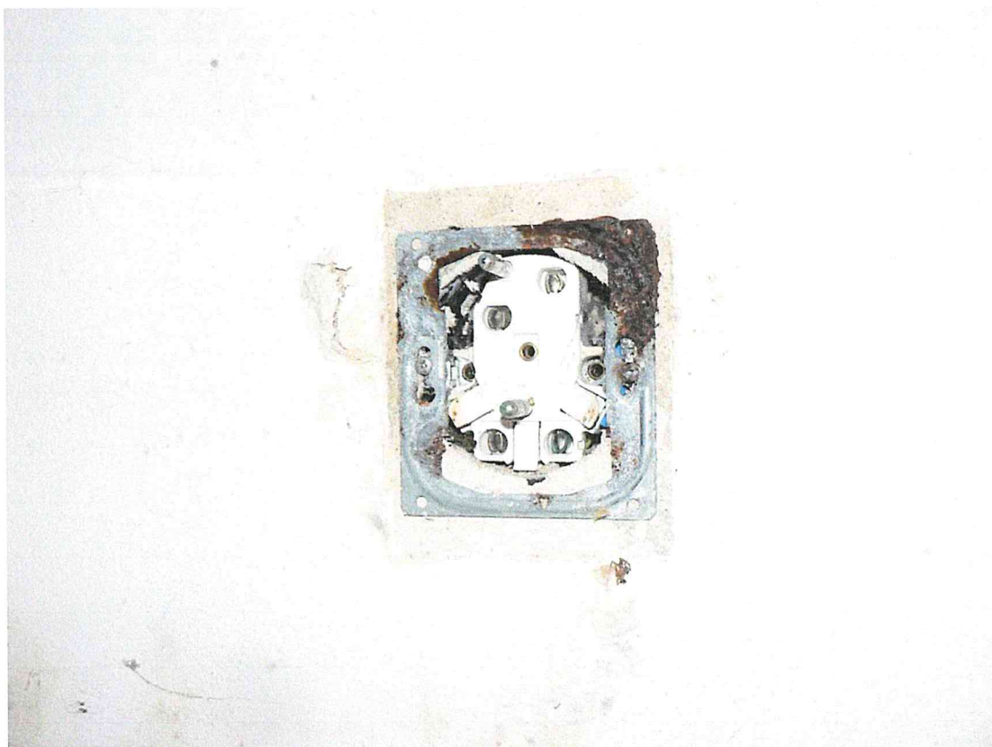
Zkorodovaná zásuvka ve skladu provozovny Zdravotní pomůcky vlivem vlhkosti.
