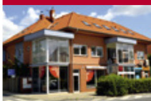
Kancelářské prostory 97m 2 Náchodská, Horní Počernice
