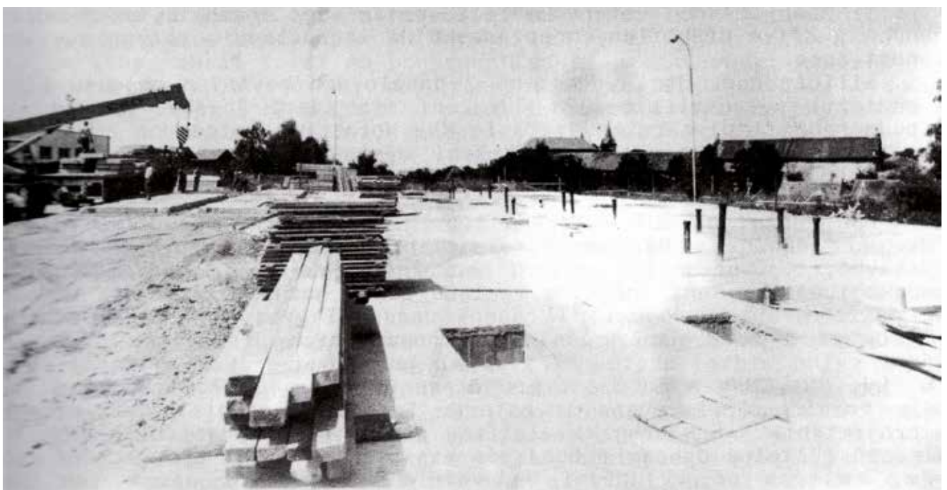
Základová deska paneláku nad údolím Chval – šestipodlažní panelák v rámci akce FMV – „Zkapacitnění sídl. I“
