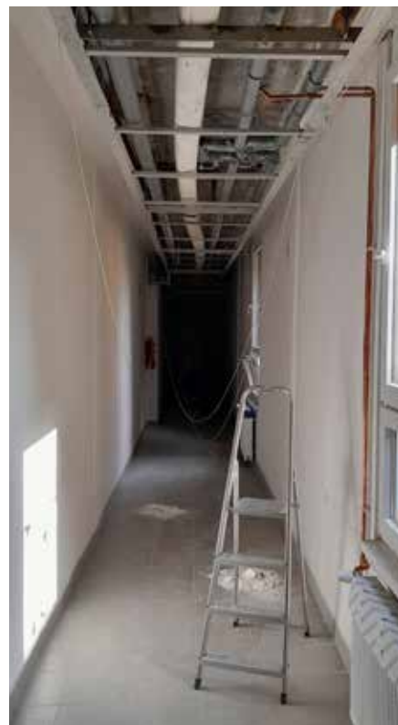
Ve spojovacím krčku v MŠ Ratibořická je měněn páteřní rozvod topení vč. radiátorů, nového podhledu a stropních světel
