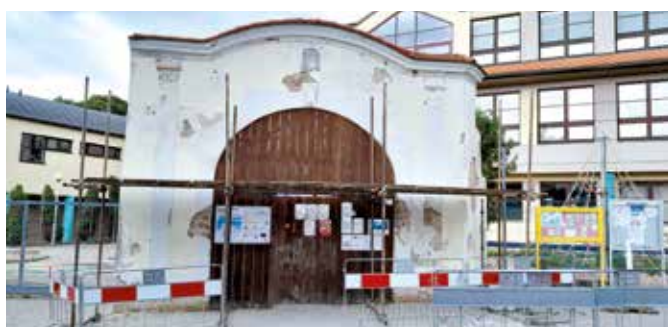
Původně venkovská usedlost, situovaná naproti kostelu sv. Ludmily, ze které se zachovala pouze brána, je nyní historickým prvkem u ZŠ Stoliňská. Přes prázdniny jsme postavili lešení, obnovují se architektonické prvky a brána dostane novou omítku. Věříme, že po dokončení prací, koncem září, upoutá pozornost nejen žáků
