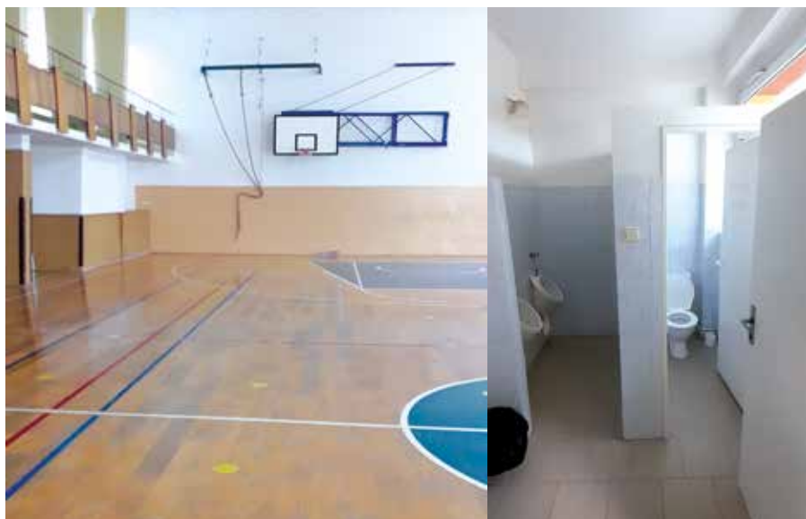
ZŠ Ratibořická bude mít spolu s novou podlahou i nová sociální zařízení u tělocvičny. Změna dispozice, nové obklady i zařizovací předměty. Tady nám práce ještě probíhají, ale v příštím Zpravodaji vám ukážeme výsledek
