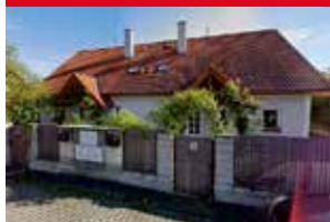
Dvojdomy Radechovská, Horní Počernice
