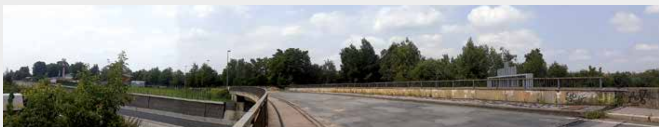
Panoramatický pohled na dálnici a zbytky mostu, červenec 2021
