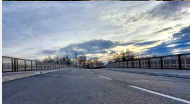
Most Božanovská těsně před uvedením do předčasného užívání
