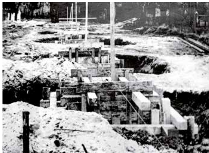
Výstavba základů nové tělocvičny Chvalkovická
