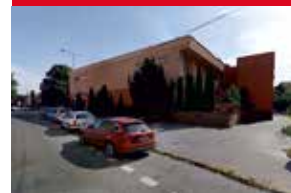
Byt 1+KK Běchorská, Horní Počernice
