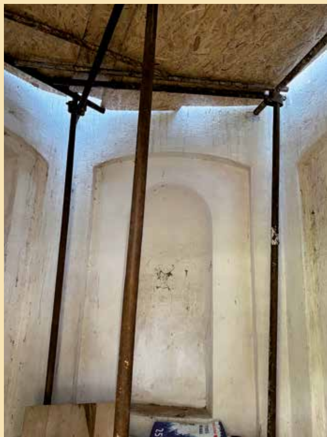
Oprava šestiboké kapličky postavené r. 1770
