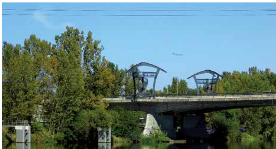
Moderní vyhlídkové plošiny na Lahovickém mostě nabízejí netradiční pohled na řeku
