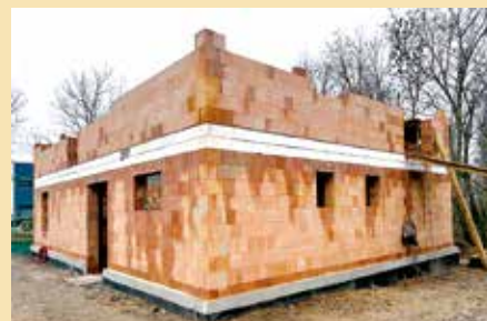
Hrubá stavba nové skautské klubovny už má jasné obrysy a roste každým dnem
