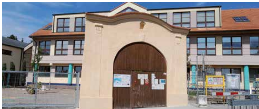
Pohled na bránu před obnovou, kdy původní vrata už neodpovídala historickému charakteru místa
