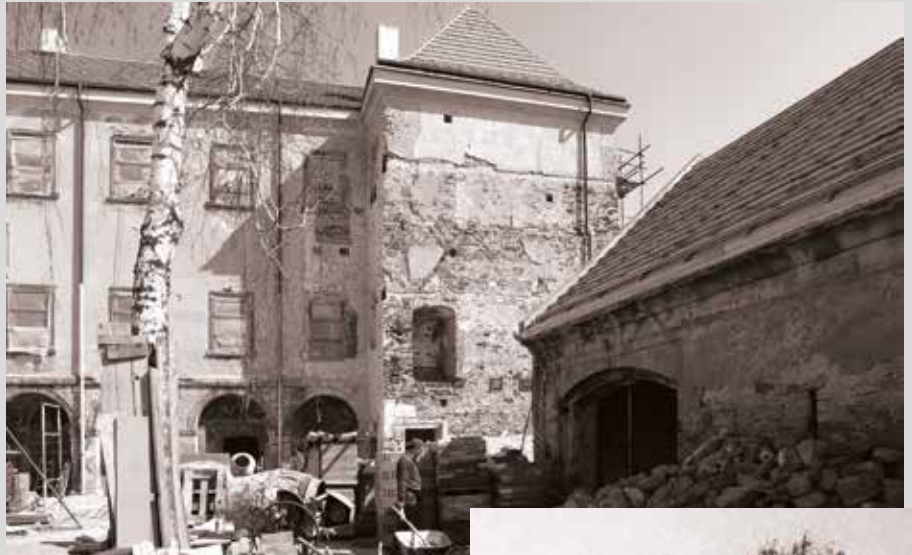
Rekonstrukce zámku, východní křídlo a kočárovna, 2006–2008
