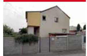
Rodinný dům Češovská, Horní Počernice
