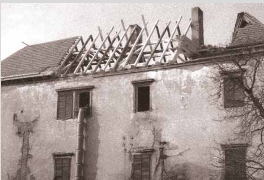
Oprava zámecké střechy na počátku nového tisíciletí
