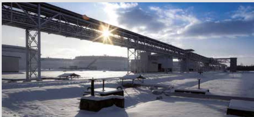
Potravní rozvody v areálu MERO, kde se setkávají ropovody Družba a IKL. Právě propojení těchto tras umožnilo České republice nahradit výpady dodávek ruské ropy alternativními zdroji a zajistit energetickou bezpečnost země
