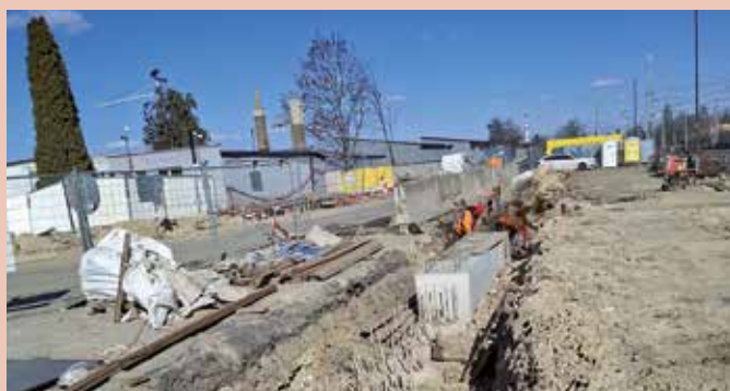
Probíhající betonáž a konstrukční práce na budoucím podjezdu v ulici Bystrá
