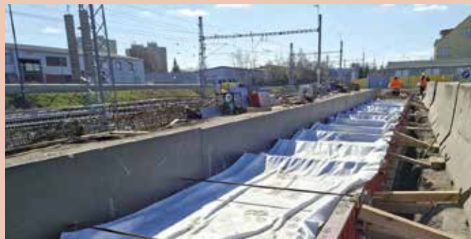
Zemní práce a zakládání konstrukcí podjezdu, stavba postupuje podle harmonogramu
