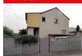
Rodinný dům Češovská, Horní Počernice
