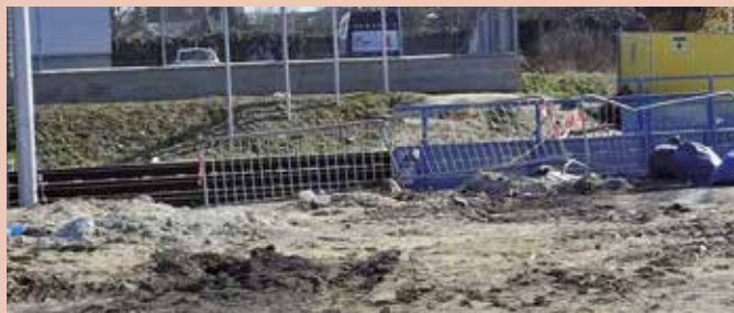
Pohled na staveniště u železniční trati
