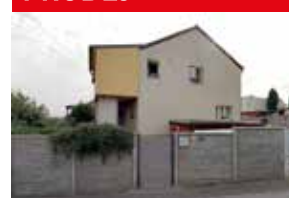
Rodinný dům Češovská, Horní Počernice
