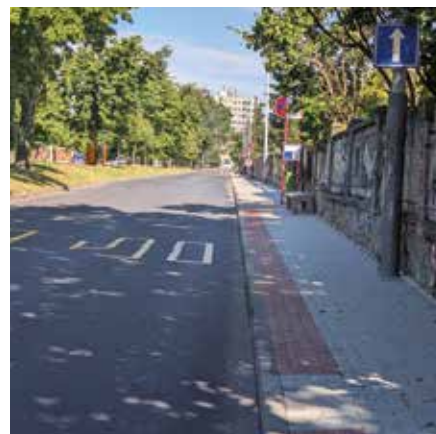
V ulici Jeřická se práce na novém chodníku blíží ke konci
