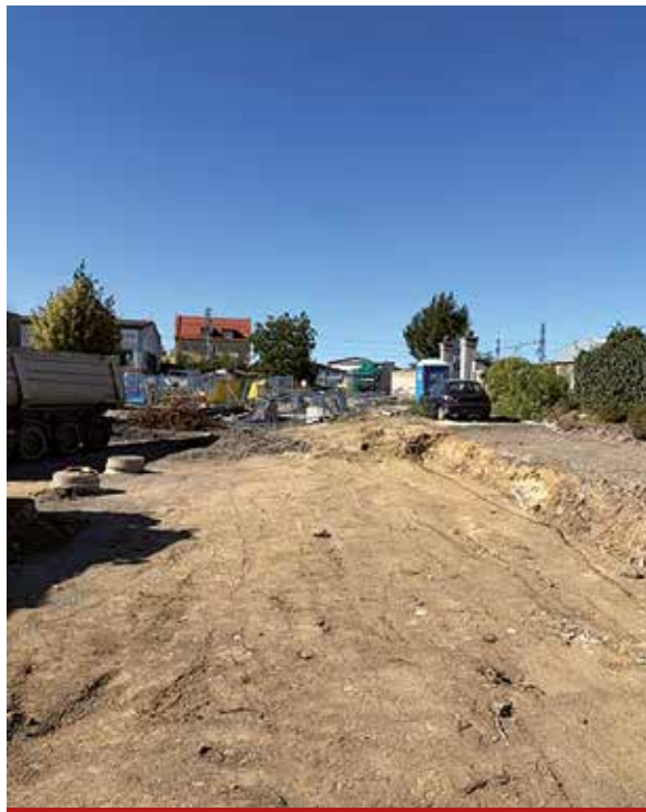
Stavební práce na podjezdu v ulici Bystrá pokračují
