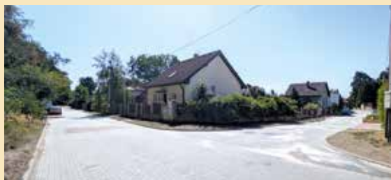
Rekonstrukce komunikací v ulicích Prachovská, Dolská a Machovská byla dokončena v plánovaném termínu
