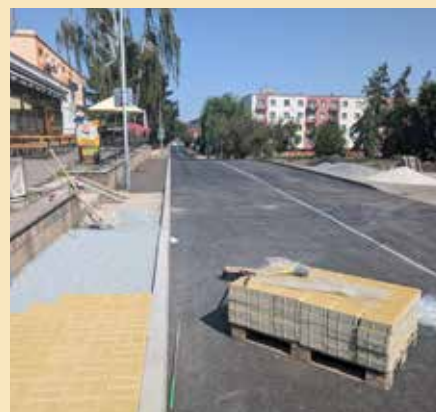
V Chodovické ulici dostala vozovka nový povrch a navázala tak na loňskou rekonstrukci chodníků
